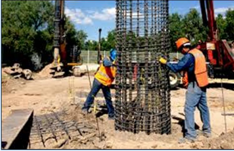
Figura II.18.- Proceso constructivo de las Pilas de Cimentación. (Foto ilustrativa).
