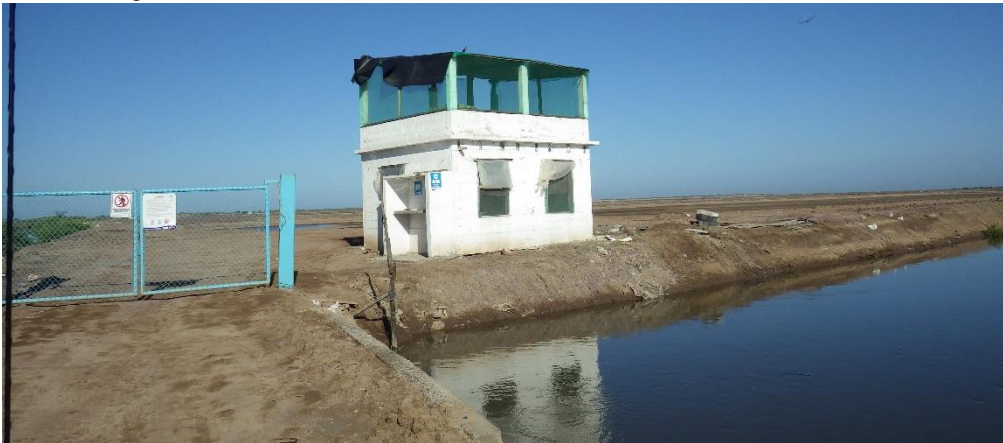
Caseta de vigilancia
