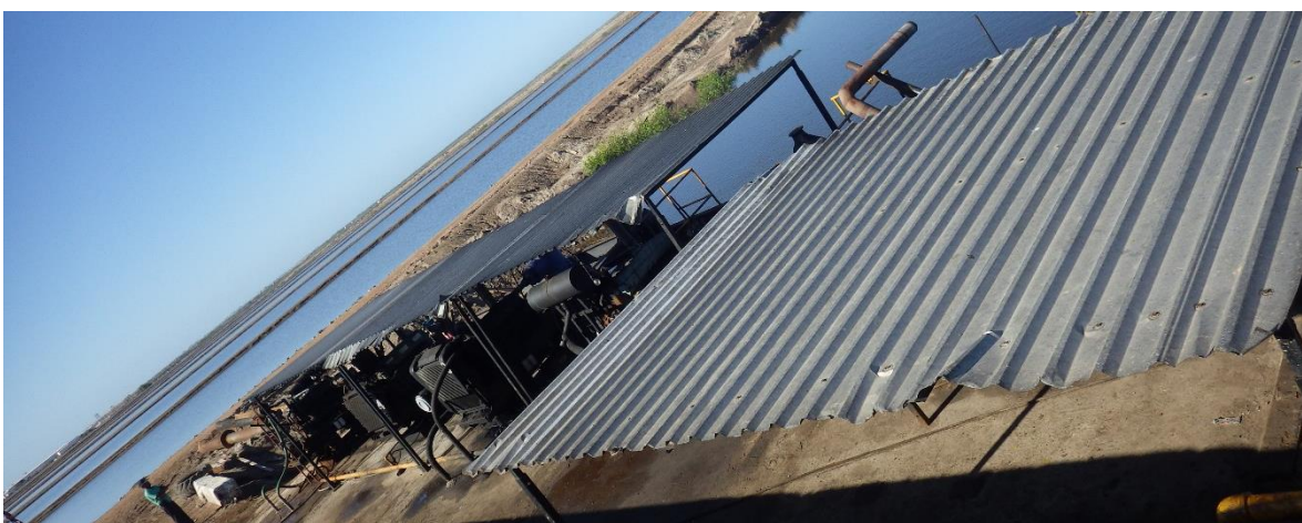
CÀRCAMO DE BOMBEO
