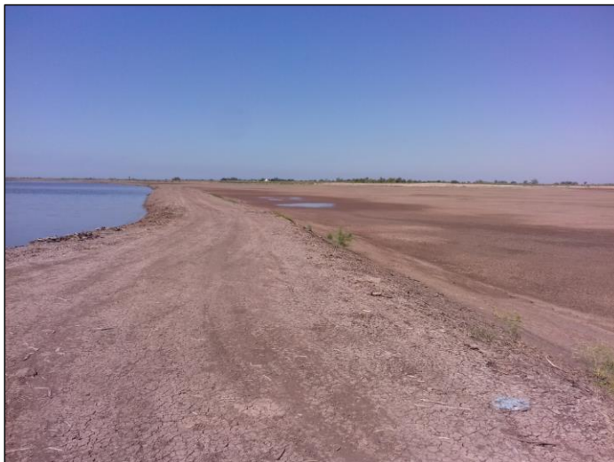
Fotografía 8.- Bordería existente dentro de la granja.
