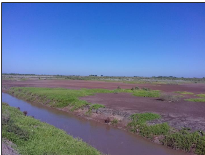
Fotografía 1.- Zona donde se construirán los nuevos estanques.
