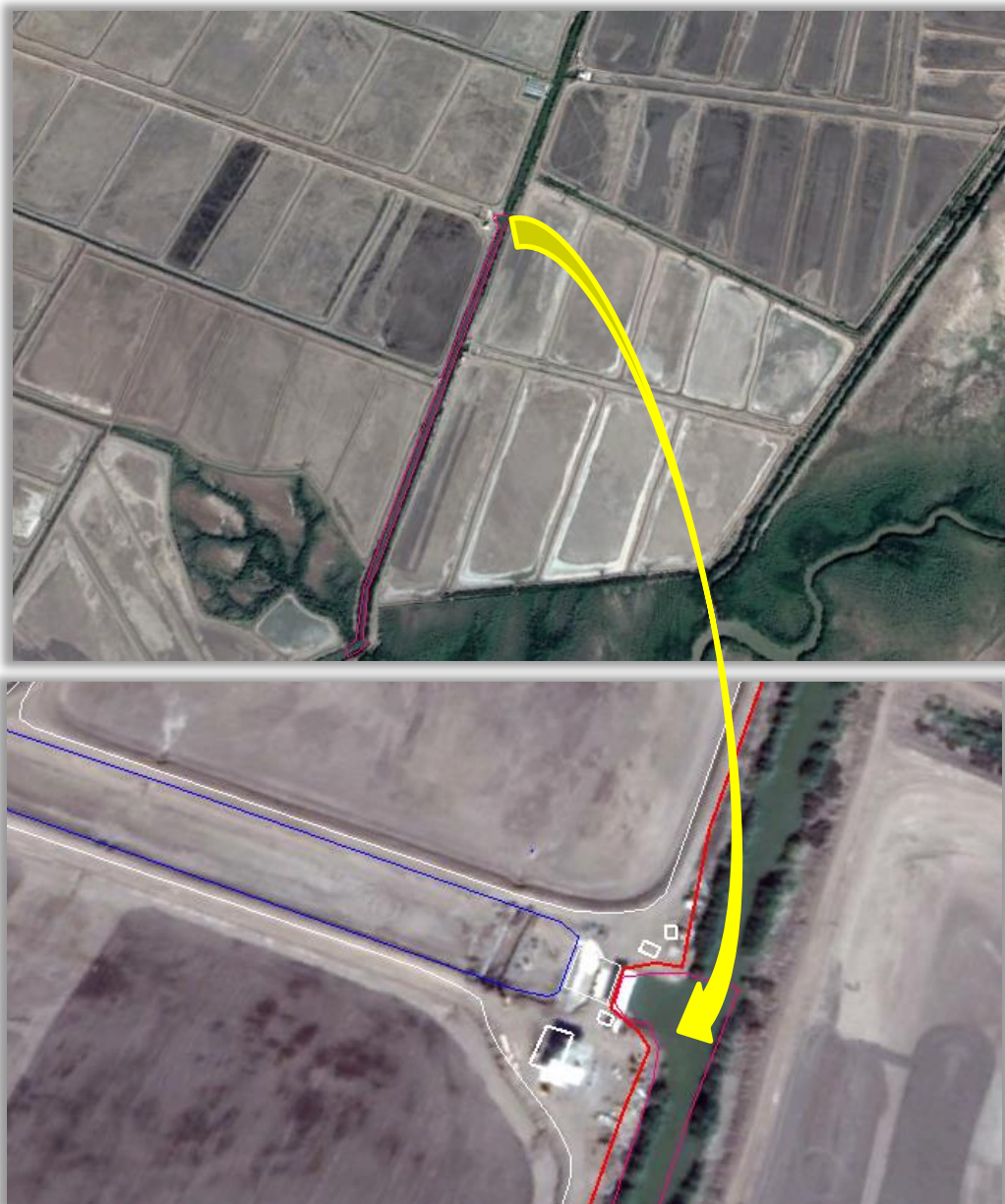
Ilustración 21.- Toma de agua del estero El Manglón, sistema lagunar Laguna Playa Colorada - Santa María La Reforma
