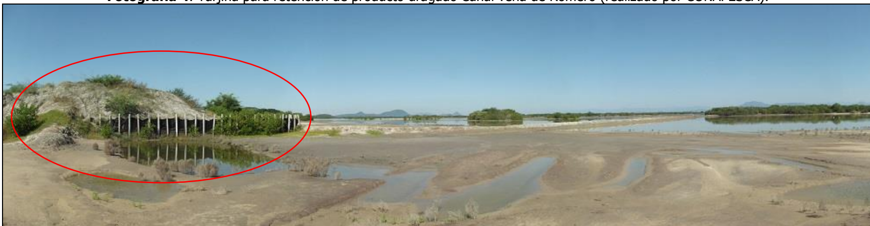
Fotografía 4. Tarjina para retención de producto dragado Canal vena de Romero (realizado por CONAPESCA).
