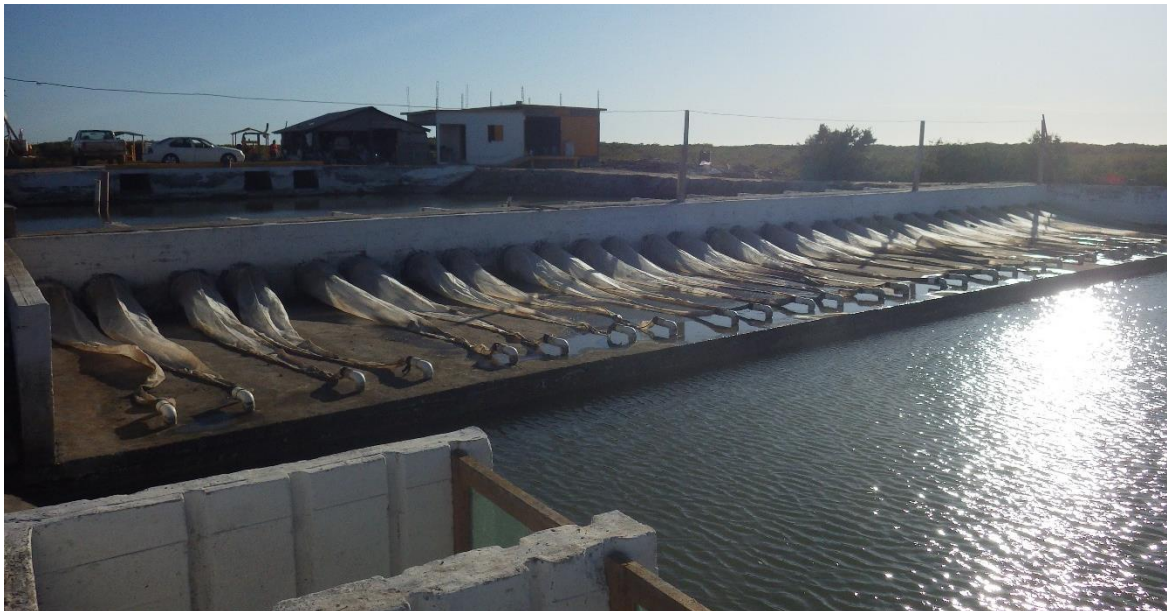
Ilustración 74.- Sistema de exclusión implementado en el reservorio.
