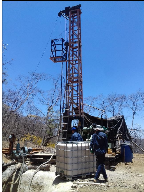
Fotografía 1. Equipo que se utilizara para los trabajos de perforación.
