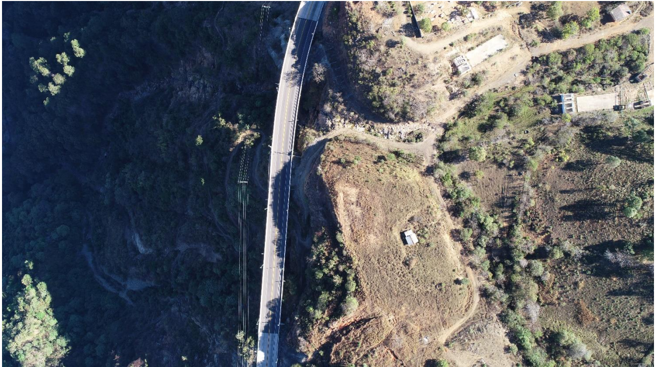
Fotografía III. 2 Vista áreas desprovistas de vegetación.
