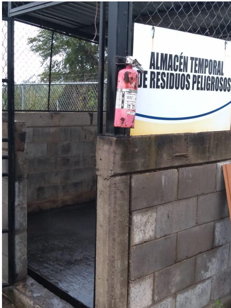
Imagen 16. Vista de almacén temporal de residuos peligrosos.
