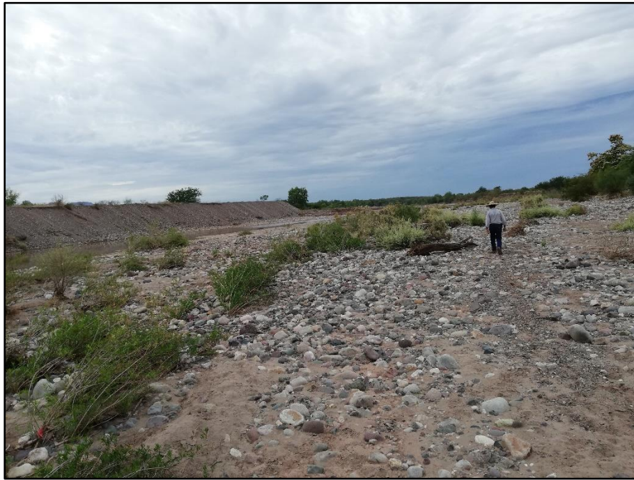
Fotografía No. 8. Conformación de terrazas en las márgenes del proyecto.
