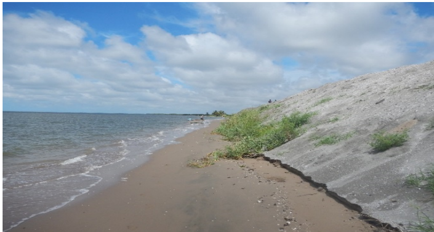
Foto 1 Vista del material con el cual se construyó el bordo (arena fina con limos)
