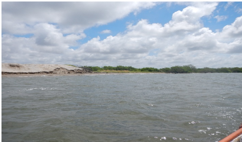
Foto 4 Vista de una zona en donde el oleaje ya empezó a erosionar el talud
