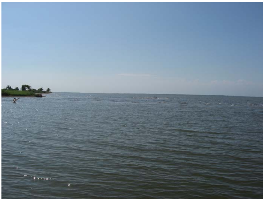
2. VISTA GENERAL DEL CANAL.
