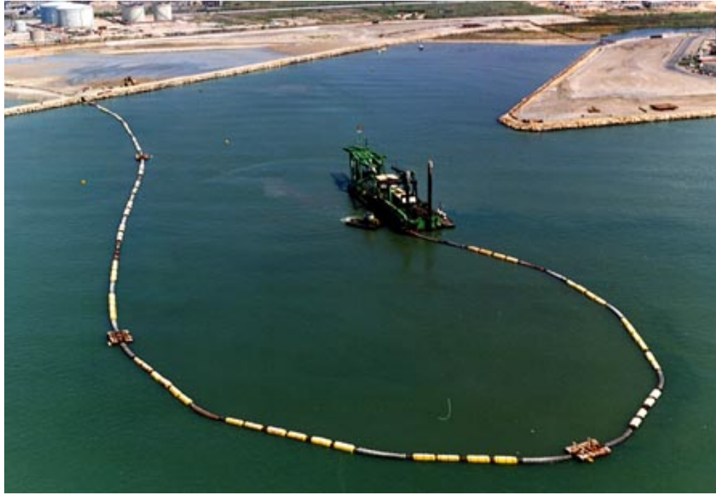
Foto 7 Tipo de draga estacionaria y tubería de descarga normalmente utilizada en este tipo de trabajos
