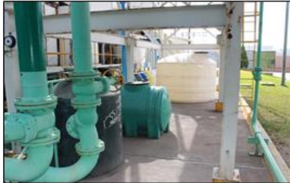
**Foto II.1.8-1.** Contenedor plástico utilizado para el almacenamiento de agua desmineralizada utilizada en el sistema de enfriamiento cerrado de la unidad generadora
