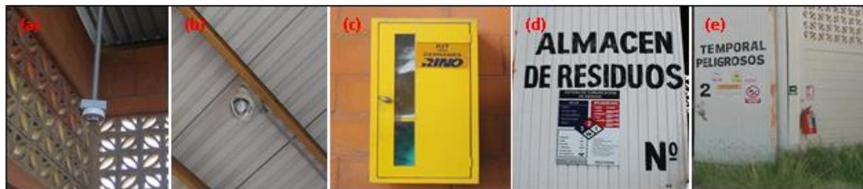
Foto II.2.3-12. Equipamiento en los almacenes de residuos peligrosos (a) alarma contra incendio, (b) lámpara contra incendio, (c) kit antiderrame, (d) señalética y (e) extintor
