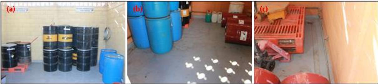
**Foto II.2.3-13.** (a) y (b) Ejemplo del manejo de los residuos en los almacenes temporales y (c) canaleta que conduce a la fosa de captación en caso de derrame de residuos peligrosos en estado líquido
