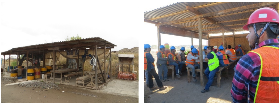
Figura II-23. Ejemplo de la habilitación de áreas para el consumo de alimentos y descanso para los trabajadores de obra durante la etapa de construcción.
