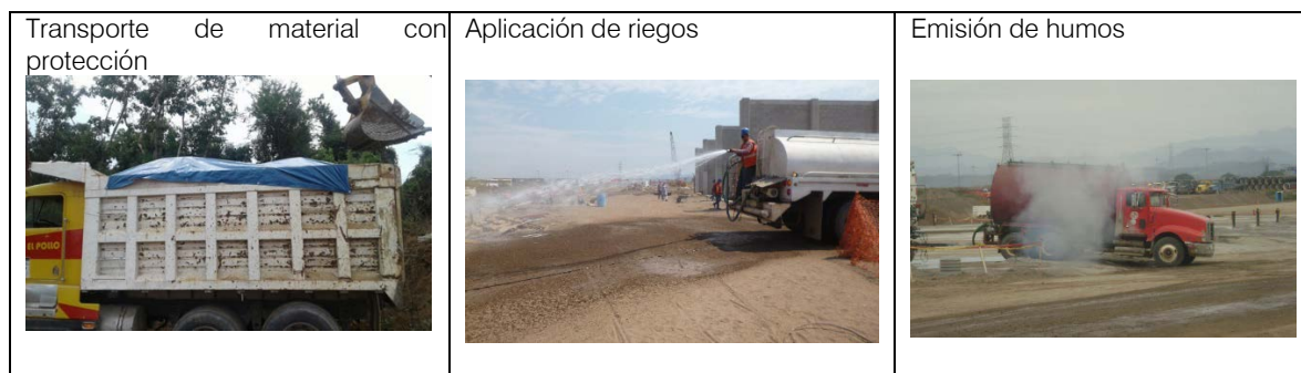
Figura II-26. Ejemplo de afectaciones ambientales y las medidas a implementar para mitigarlas durante las etapas de preparación del sitio y construcción del proyecto.
