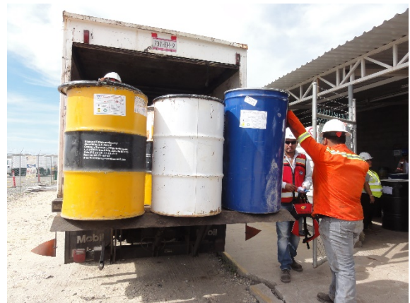
Retiro y transporte de residuos peligrosos por una empresa autorizada para su manejo y disposición final.
