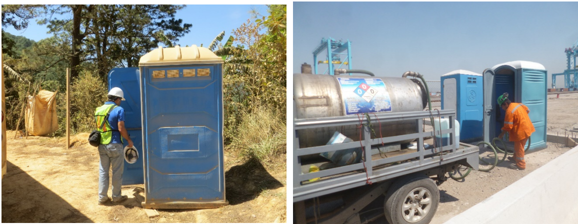
Figura II-24. Ejemplo de la habilitación y mantenimiento de baños portátiles instalados en frentes de trabajo para uso de los trabajadores.
