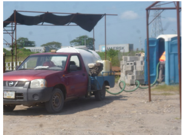
Mantenimiento a baños portátiles en un frente de trabajo por personal de una empresa especializada.
