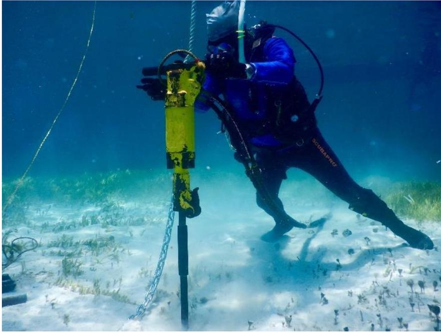
Figura 4.- hundimiento del anclaje manta raya con un martillo hidráulico.
