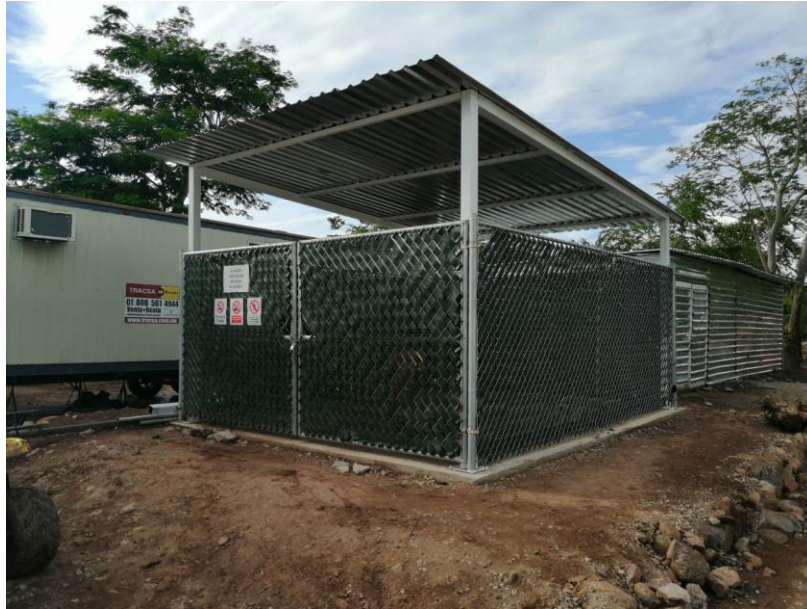
Figura II-28. Sitio para la disposición de residuos peligrosos.
