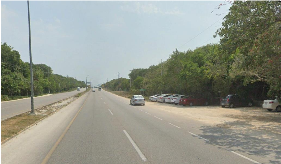
Figura 14. Carretera federal N° 307
