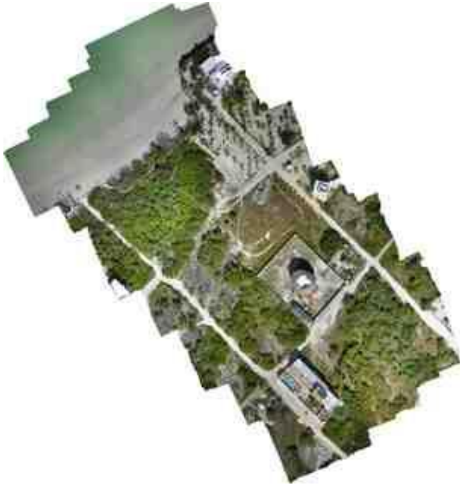
Figura 54. Ortofotografía obtenida a partir de la fotogrametría realizada al sitio de estudio del proyecto.
