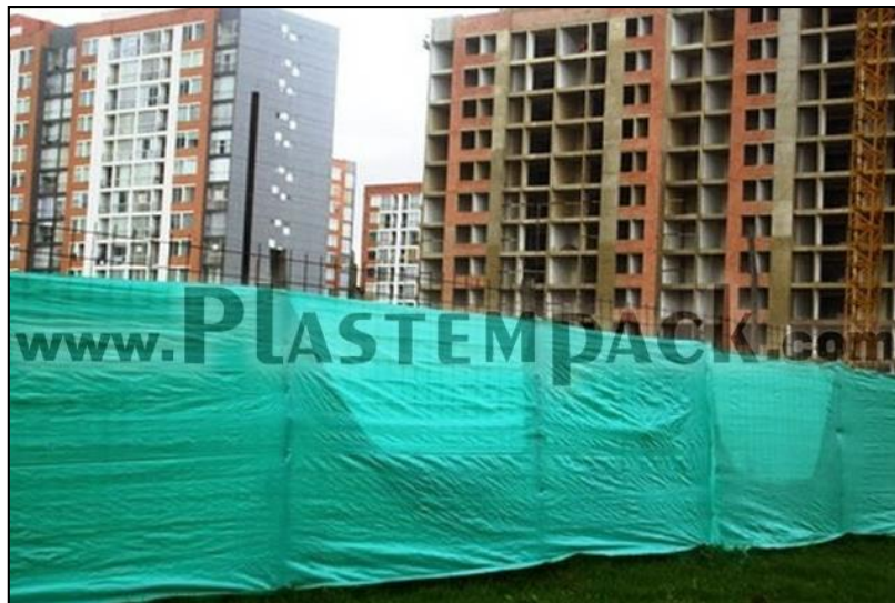
Figura 6. Forma de utilizar la malla para la delimitación del área de trabajo.
