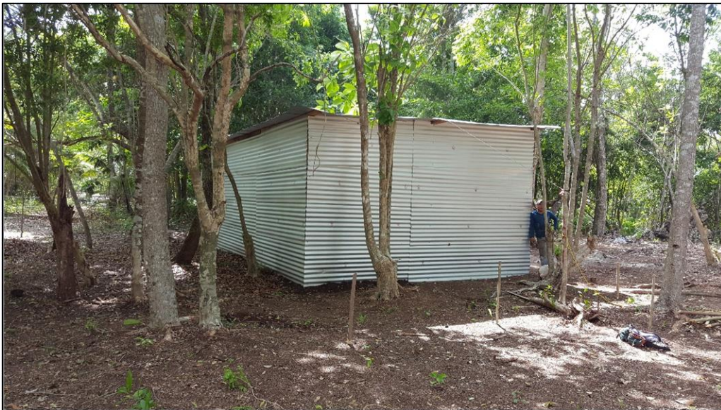
Figura 11. Bodega provisional para resguardo de materiales y herramientas.
