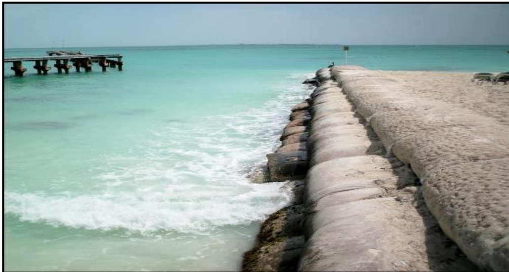
Figura 2.64. Apariencia final de una estructura de protección construida con bolsacreto.
