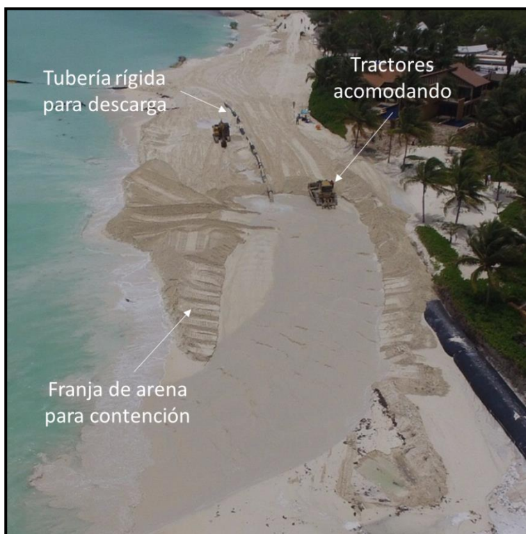
Figura 2.75. Descarga de mezcla agua-arena en la playa con tubería rígida y maquinaria de apoyo para acomodar la arena vertida.
