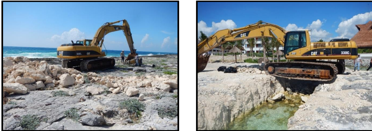
Figura 2.66. Uso de maquinaria para la demolición y excavación de las caletas.
