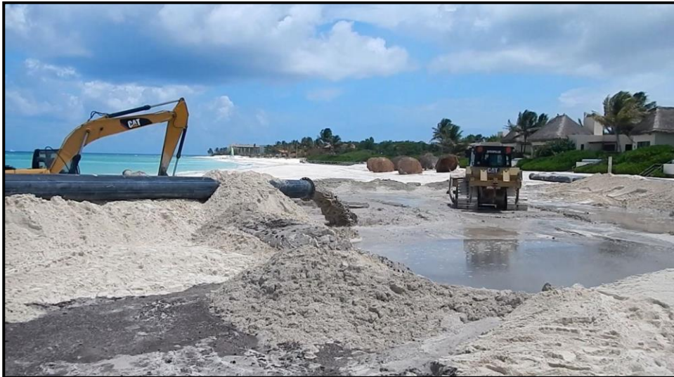
Figura 2.74. Vertimiento y acomodo de arena con maquinaria pesada.
