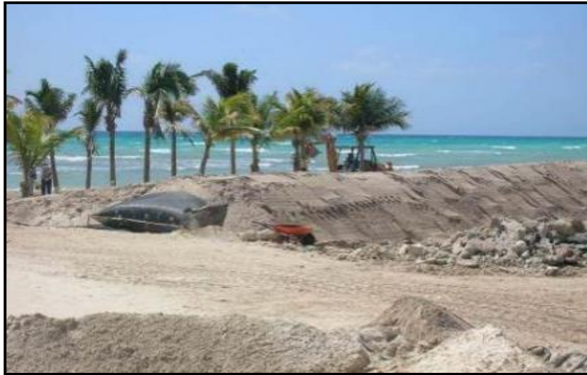
Figura 2.53. Tubo de geotextil a ser cubierto con arena.
