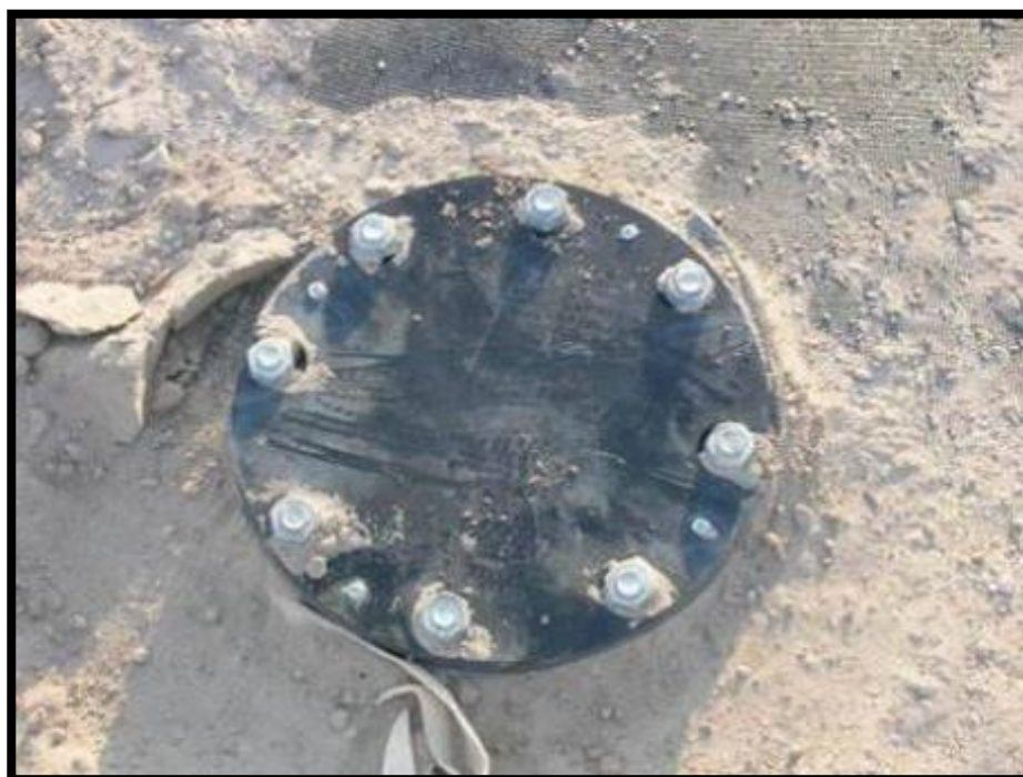
Figura 2.42. Cerrado de las bocas de llenado con tapa atornillada.
