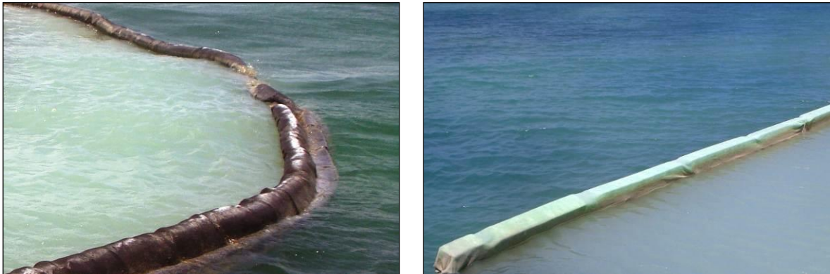
Figura 2.37. Ejemplos de cortinas antidispersión de finos.
