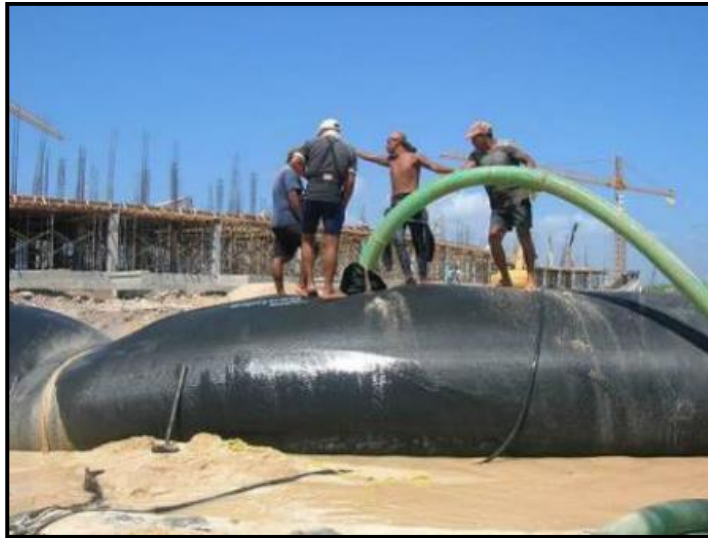
Figura 2.47. Llenado de tubos de geotextil.
