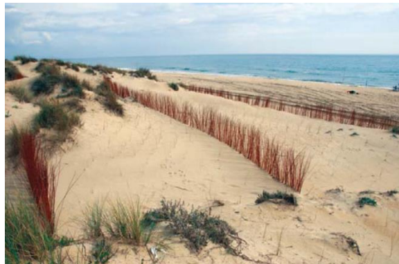
Figura 7. Ejemplo de captadores pasivos de arena.
