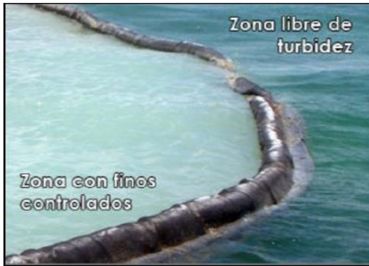
Figura 6. 6. Ejemplo de instalación de cortina antidispersión de sedimentos.
