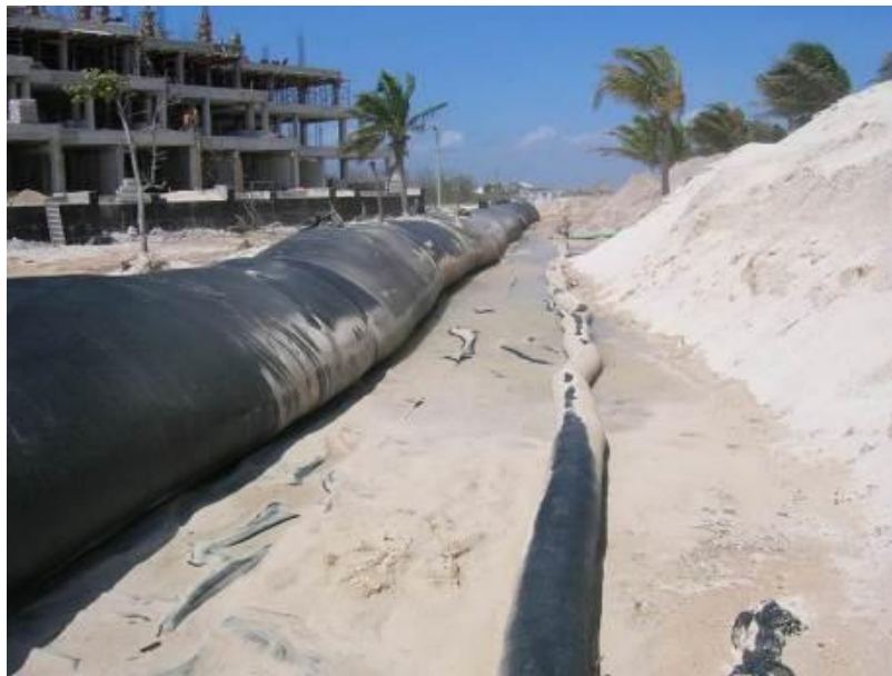
Figura 6. 9. Geotubo relleno y tubo de anclaje.
