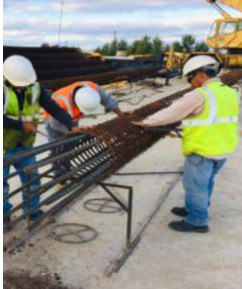
Fig. II.9 Armado de estructuras internas para los pilotes. Fuente: Proporcionado por el promovente.
