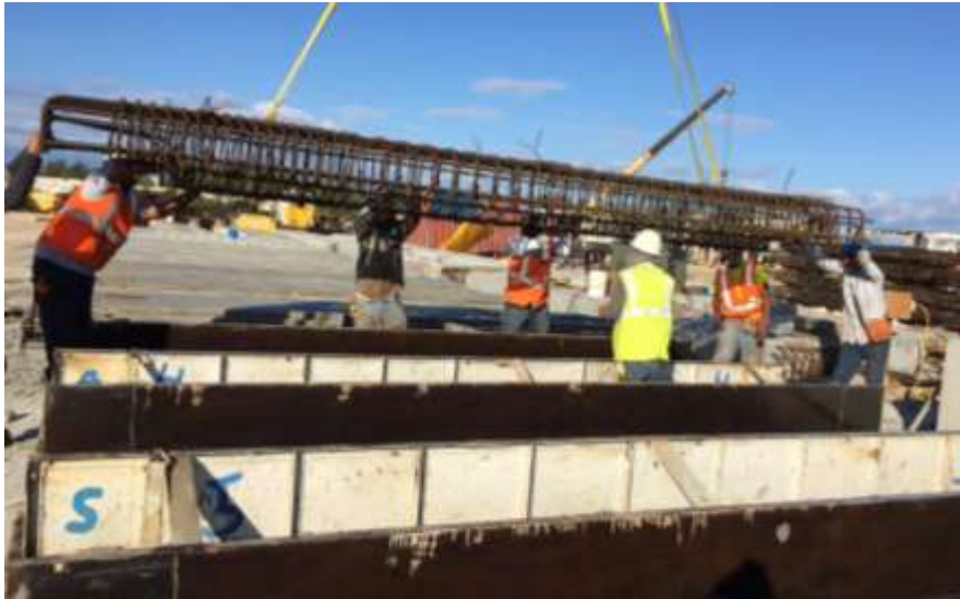
Fig. II.14 Colocación de armado en la cimbra Fuente: Proporcionado por el promovente.
