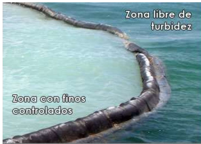
Fig. II.2 Colocación de malla geotextil para control de finos suspendidos.
