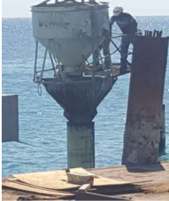
Fig. II.11 Colado con concreto para fijar el acero de refuerzo. Fuente: Proporcionado por el promovente.
