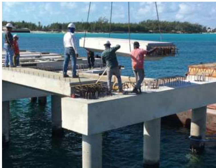
Fig. II.17 Montaje de losas prefabricadas.
