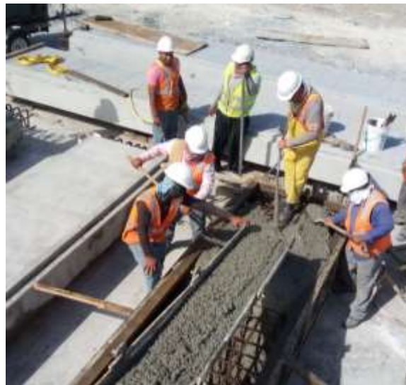
Fig. II.15 Colado de traves y losas. Fuente: Proporcionado por el promovente.
