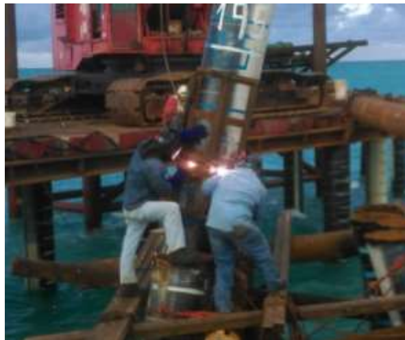
Fig. II.8 Acoplamiento de sección de tubo. Fuente: proporcionado por el promovente
