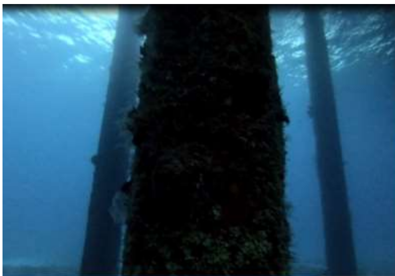
Fig. IV. 57 Cubrimiento por algas y otros organismos bentónicos de un pilote del muelle Cozumel Cruise Excursions.
