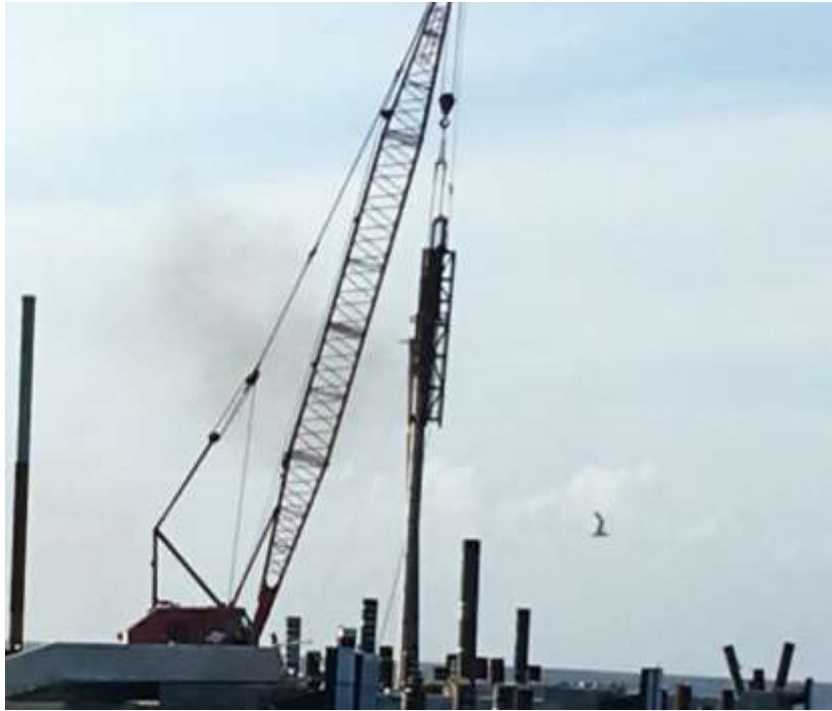
Fig. II.7 Hincado de pilotes. Fuente: proporcionado por el promovente.
