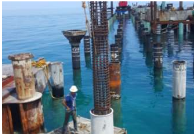
Fig. II.10 Colocación de armado dentro del tubo de acero. Fuente: Proporcionado por el promovente.
