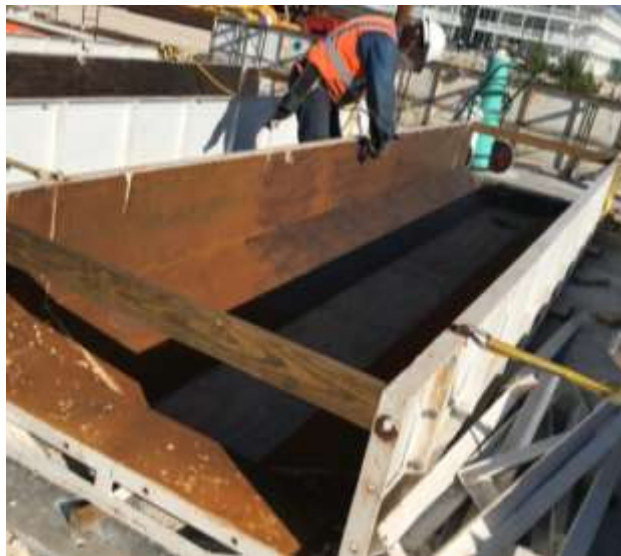
Fig. II.13 Cimbra para elementos prefabricados. Fuente: Proporcionado por el promoviente.
