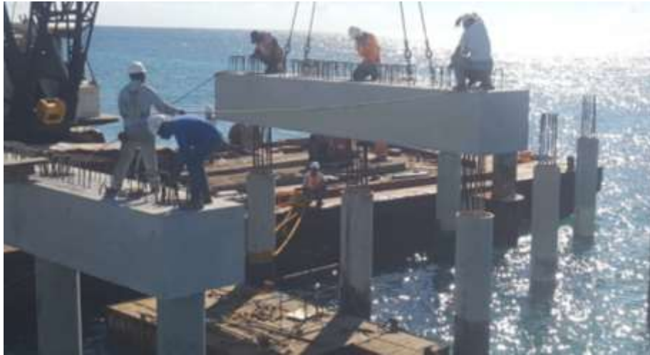
Fig. II.16 Montaje de travesaños prefabricados.
