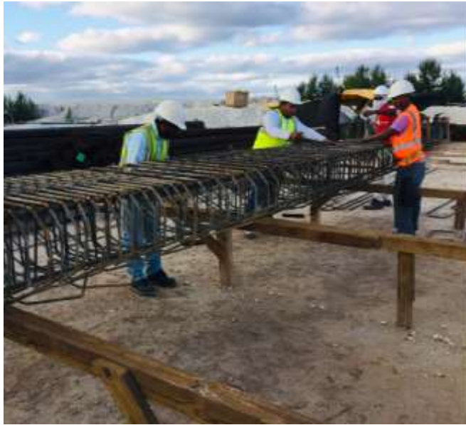
Fig. II.12 Armado de acero de refuerzo para traves. Fuente: Proporcionado por el promoviente.
