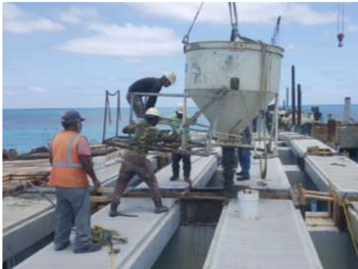
Fig. II.19 Colado con concreto de uniones entre trabes y losas.
