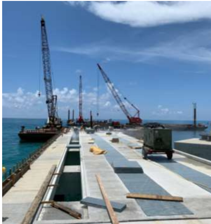
Fig. II.21 Colocación de rejillas tipo Irving. Fuente: Proporcionado por el promovente.
