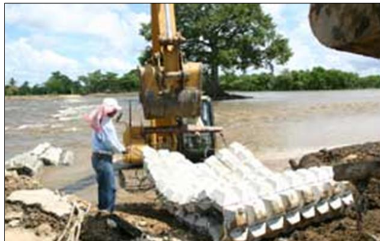
Figura II-21. Ejemplo de colocación de tapete de concreto.
