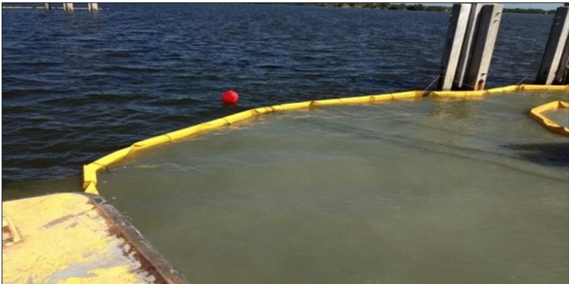
Figura II-18. Ejemplo de funcionamiento de malla geotextil.
