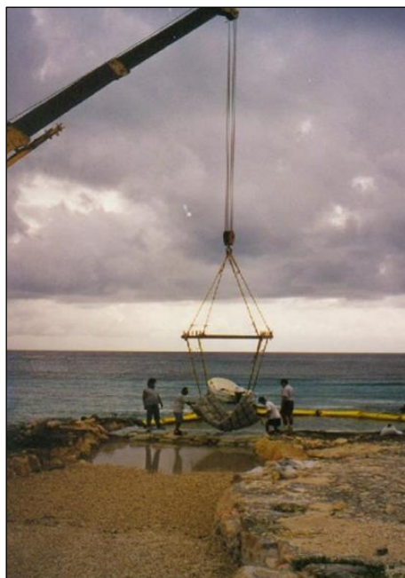
Figura II-23. Ejemplo de instalación de tapete de concreto.
