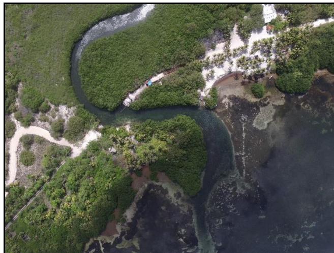
Figura 28. Vista aérea de la zona de construcción del Puente Río Huach, que unirá el camino de Terracería entre Xcalak y Mahahual Q. Roo.
