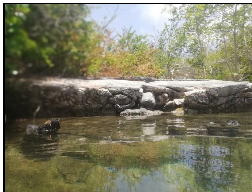
Figura 33. Zona donde se construirá el Puente de Río Huach.
