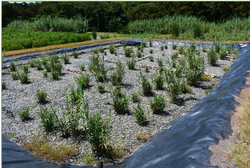
Figura 1. Ejemplo de un humedal de flujo horizontal subsuperficial.
