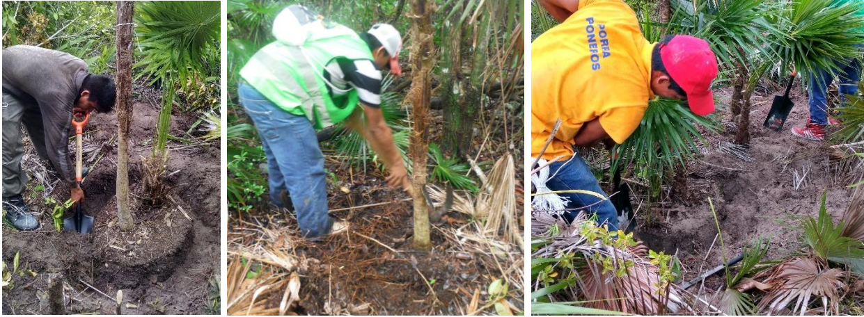
Construcción de la zanja de banqueo
