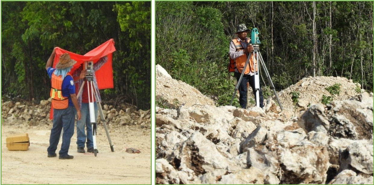
Figura 11. Trabajos de topografía en campo durante el desarrollo de una obra
