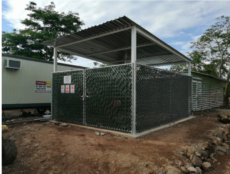
Figura VI-3. Ejemplo de un almacén temporal de residuos peligrosos.
