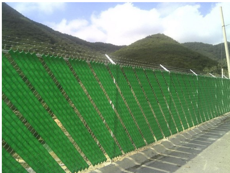
Figura II-34. Ejemplo cercado de maya ciclón para delimitar el área temporalmente.
