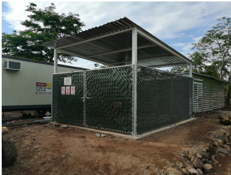
Figura II-37. Sitio para la disposición de residuos peligrosos.
