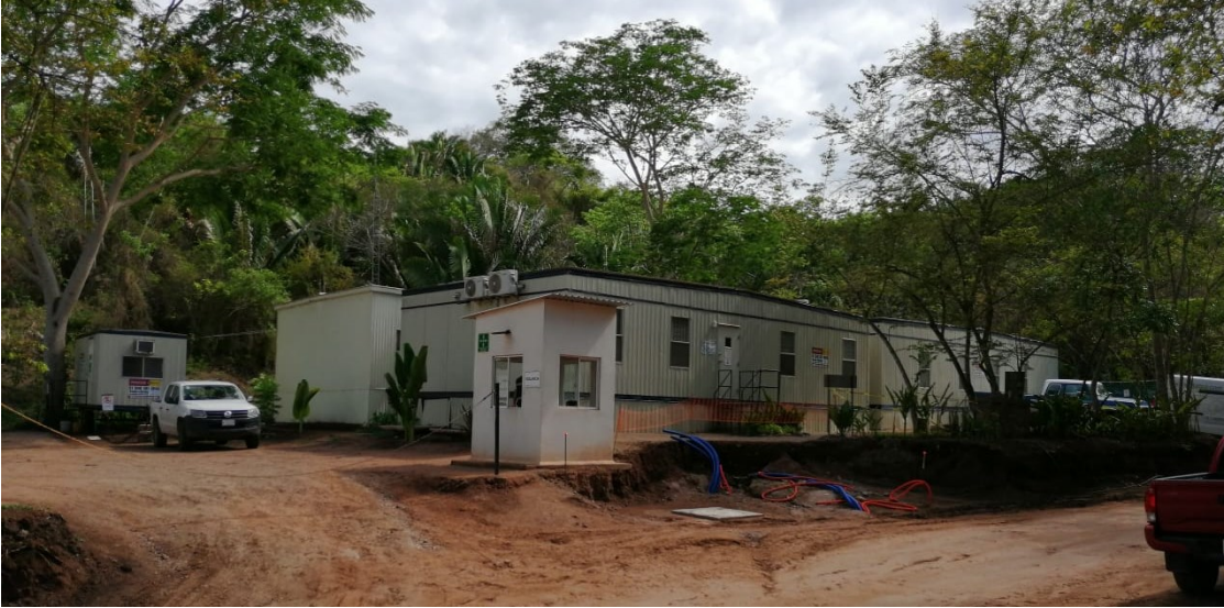
Figura II-35. Ejemplo de zona habilitada con oficinas móviles del tipo que se proponen.
