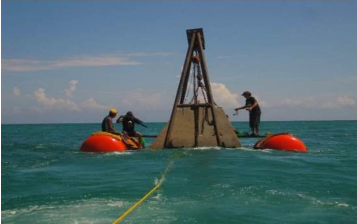
Figura 23. Tipo de barcaza o contenedor flotante con el cual se transportarán las piezas que formarán los arrecifes artificiales.
