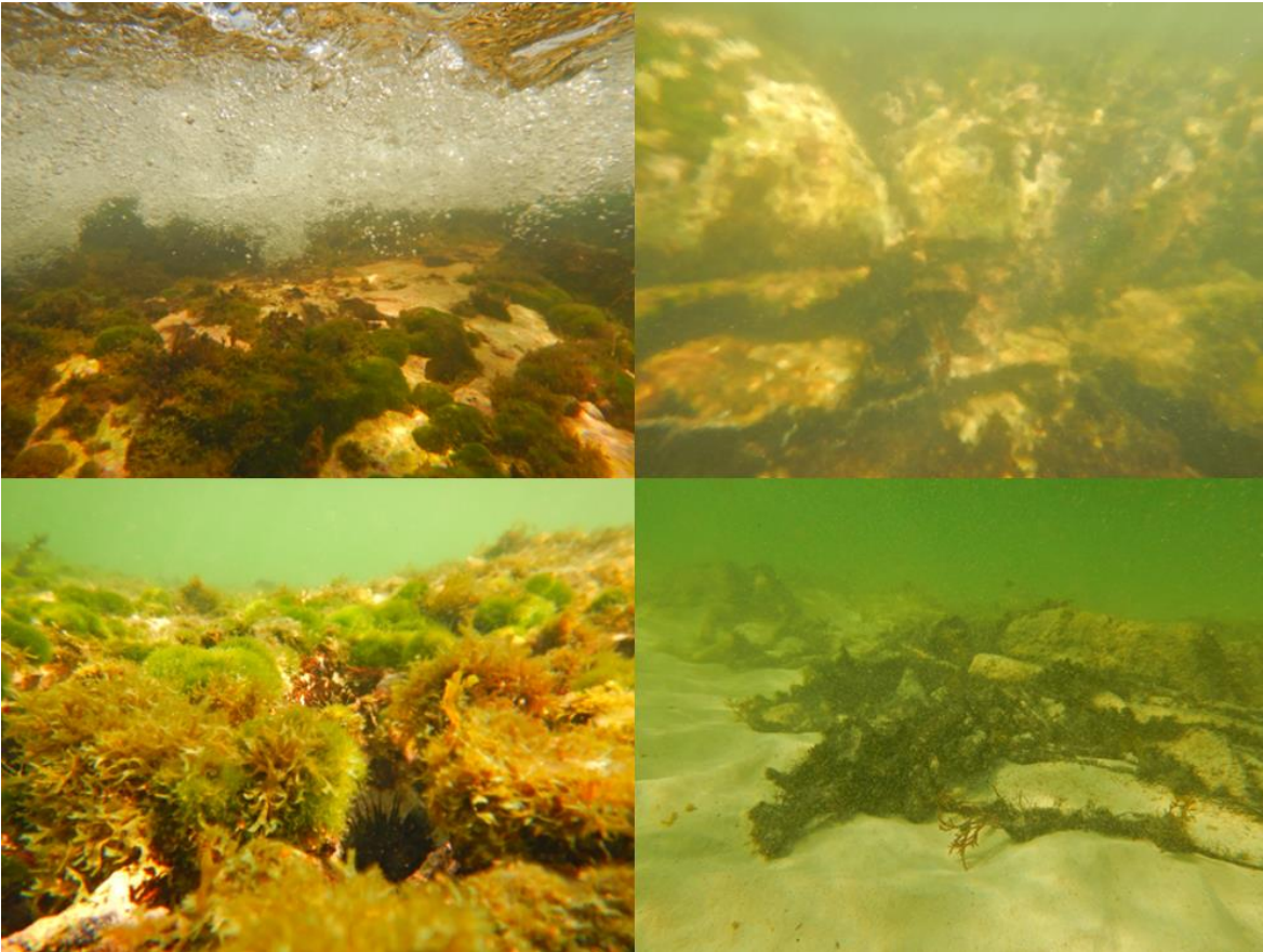
Figura 114. Vistas submarinas de las estructuras de protección existente frente al hotel Sandos Caracol, sección Sur expuesto (S-exp) en el muestreo de la época de lluvias. Arriba izquierda: parte somera de la estructura; arriba derecha: apilamiento de bolsacretos; abajo izquierda: tipo de vegetación que crece sobre la estructura; abajo derecha: basura que se encuentra en la parte profunda de la estructura.
