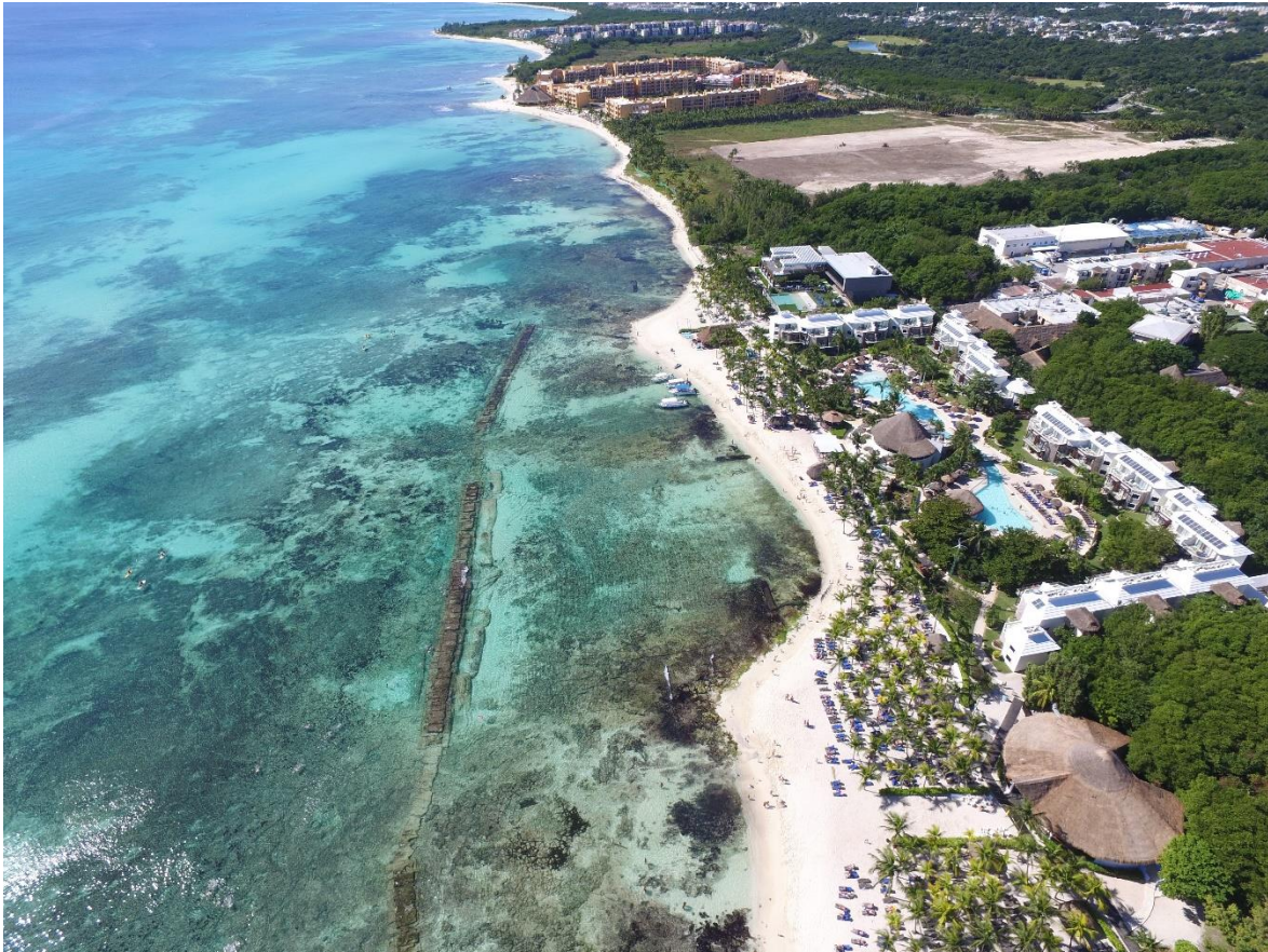
Figura 4. Vista aérea de las estructuras de protección costera existentes frente al Hotel Sandos Caracol Eco Resort.
