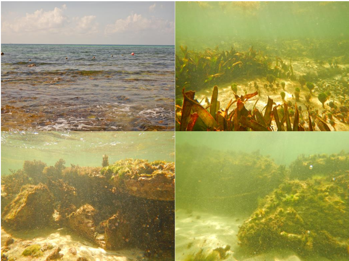
Figura 112. Vistas submarinas de las estructuras de protección existente frente al hotel Sandos Caracol, sección Sur somero (S-som) en el muestreo de la época de lluvias. Arriba izquierda: vista desde superficie; arriba derecha: parche de pasto marino y algas; abajo izquierda: acumulación de piedras sobre sustrato de laja; abajo derecha: bolsacretos sobre sustrato de arena.
