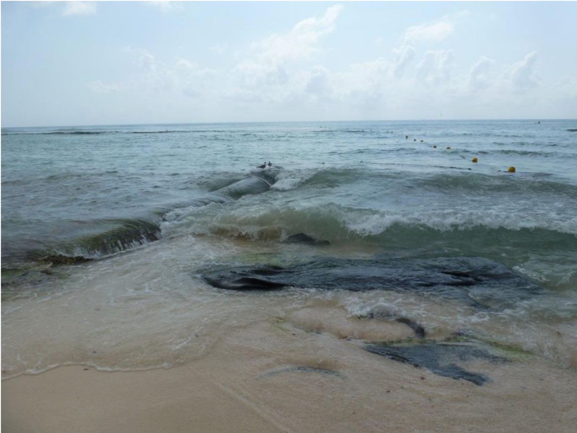
Figura 2. Las estructuras sumergidas de geotextil y sus superficies curvas y suaves (Parte superior de la imagen) permiten que las olas pasen sobre la estructura y se impacten con la playa.
