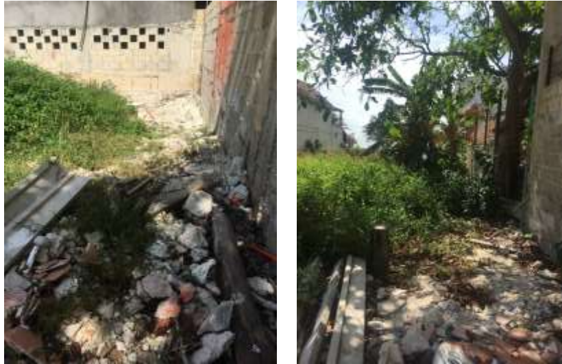
Foto II-14. Basura y restos de escombros que se observan dentro del predio.
