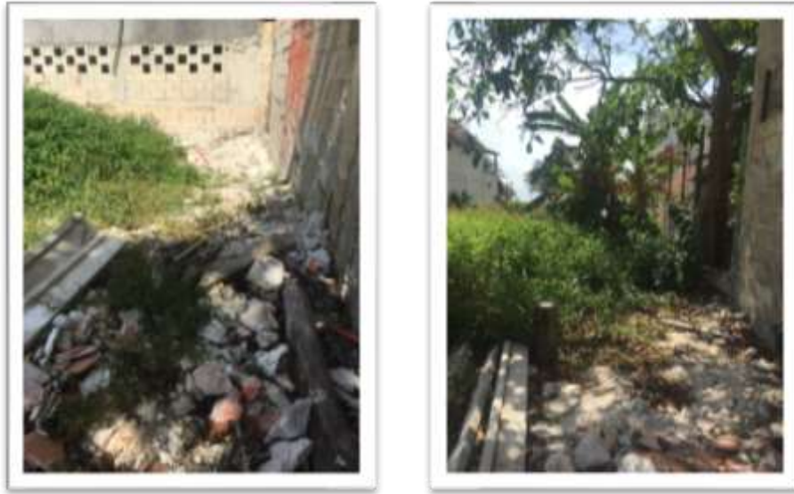
Foto V-1. Basura y restos de escombros que se observan dentro del predio.
