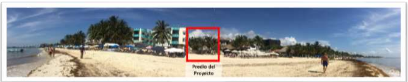
Foto II-5 Vista general de la zona donde se ubica el predio del proyecto.
