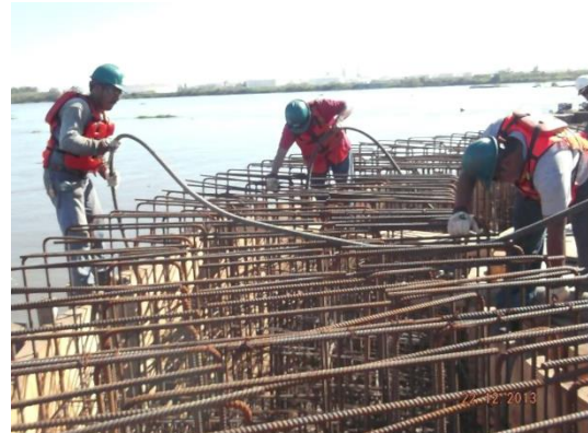
Figura II-24. Habilitado de acero y cimbrado de superestructura.
