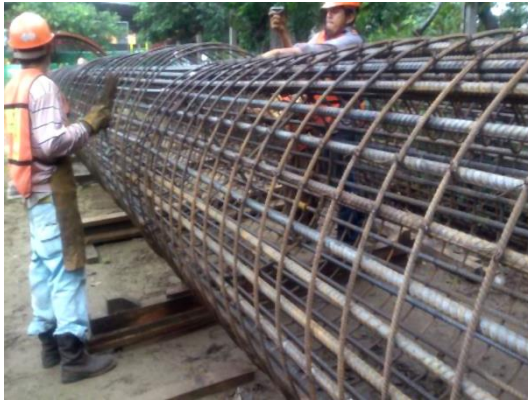
Figura II-17. Habilitado de acero para las pilas.
