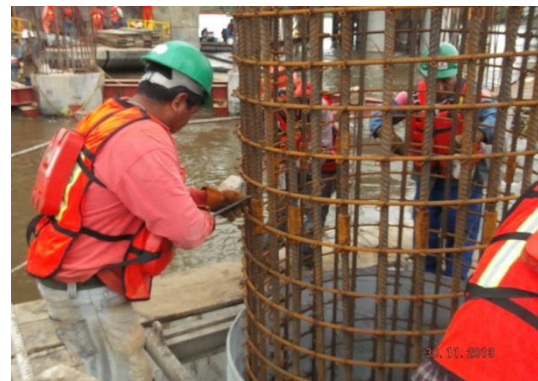
Figura II-22. Hincado del armado de acero.
