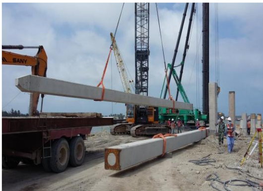
Figura II-30. Hincado de pilotes prefabricados para la extensión de la pasarela.
