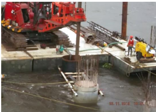
Figura II-21. Hincado del armado de acero.
