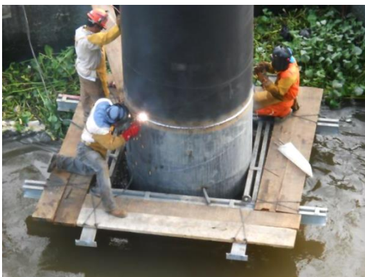
Figura II-15. Soldadura para unión del ademe con escantillón.
