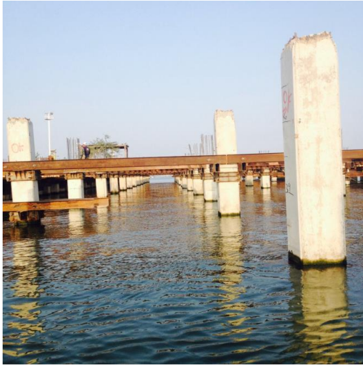
Figura II-32. Descabece de pilotes prefabricados dejando las varillas y los torones sin daño.
