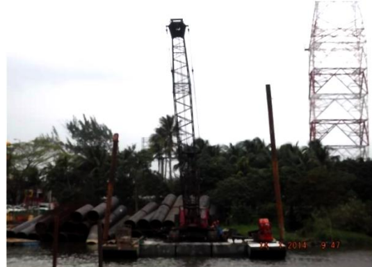
Figura II-12. Maquinaria Torre Grúa para la guía e hincado de los elementos constructivos de la pila.
