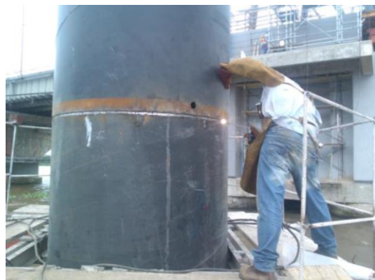
Figura II-16. Unión del ademe con escantillón.
