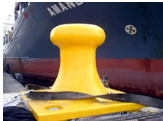
Figura II-26. Instalación de bita de amarre de 100 Toneladas.
