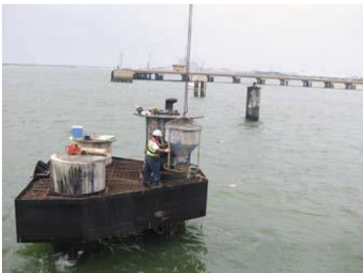
Figura II-25. Colado de plataforma de duque de alba.
