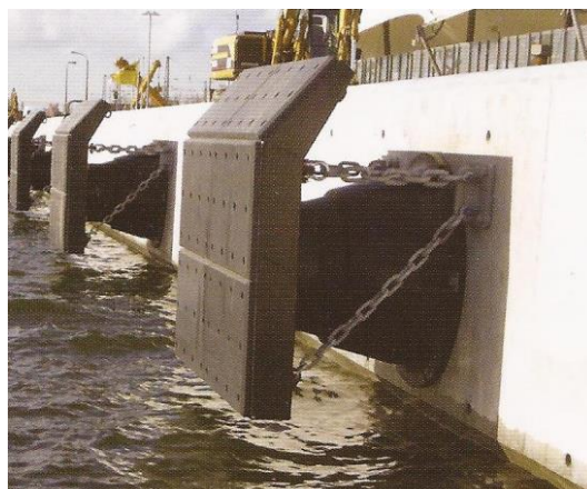
Figura II-27. Instalación de defensa.
