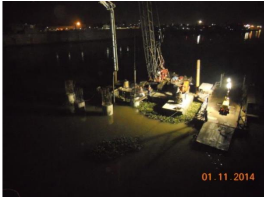
Figura II-23. Colado de pilas para el duque de alba.
