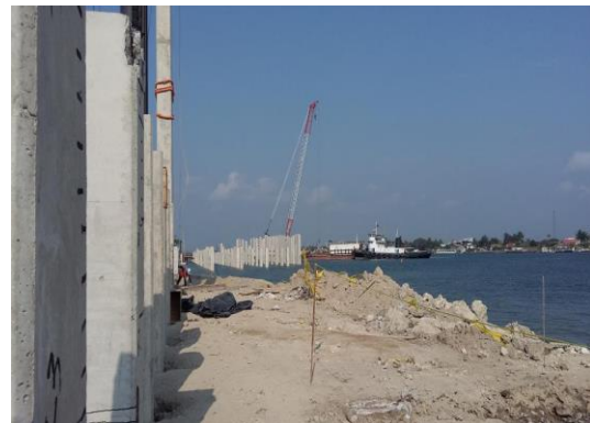
Figura II-31. Hincado de pilotes prefabricados para la extensión de la pasarela.
