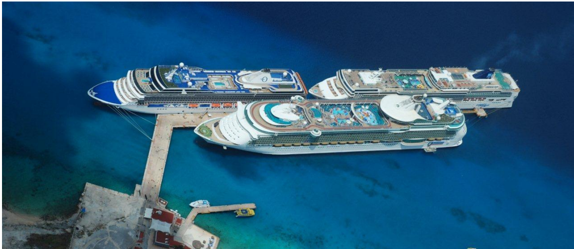
Figura II-39. Fotografía aérea del estado actual de operación del muelle.
