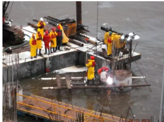
Figura II-14. Revisión del nivel del escantillón con topografía.
