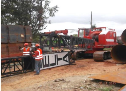
Figura II-11. Instalación de la maquinaria Torre Grúa para la guía e hincado de los elementos constructivos de la pila.
