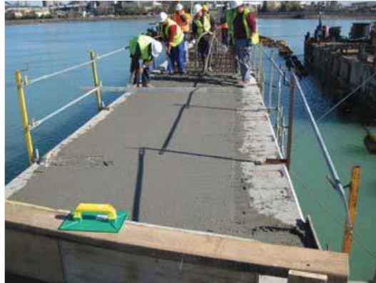
Figura II-36. Tendido de sobre losa en los tableros de la pasarela.
