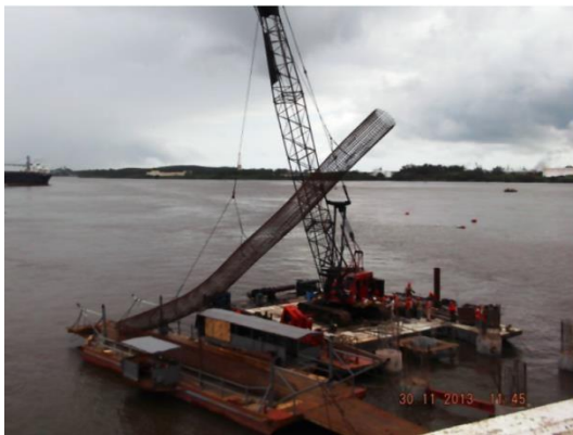
Figura II-19. Levantamiento del armado de acero con grúa.
