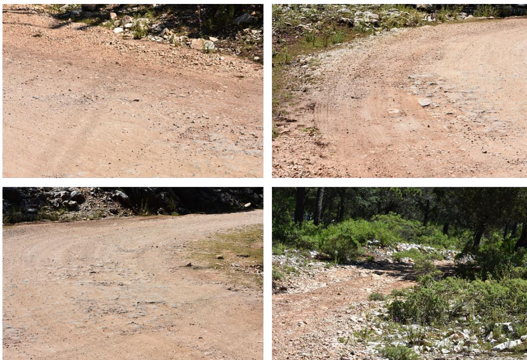
Figura 81. Condiciones actuales del escurrimiento superficial localizado en el km 6+430.
