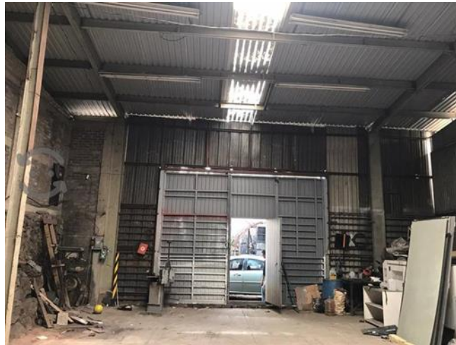
Figura 30. Ejemplificación de un Almacén de Materiales en Obra
