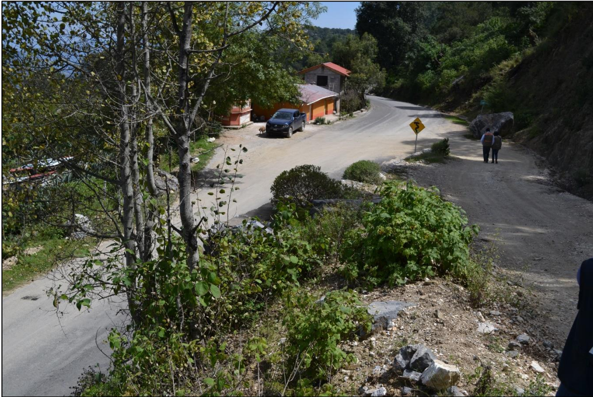
Figura 140. Condiciones generales de la sección final del camino con el entronque, se observan áreas desprovistas de vegetación limitando con vegetación secundaria de bosque de encino.
