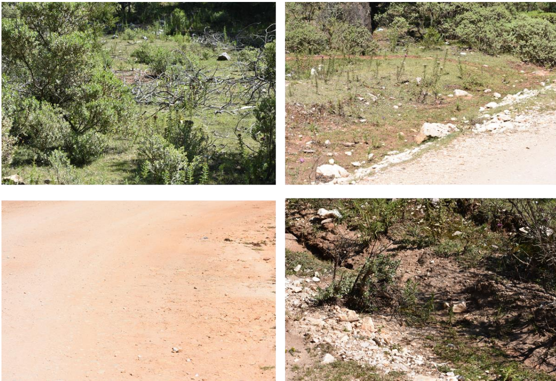
Figura 79. Condiciones actuales del escurrimiento superficial localizado en el km 5+983.
