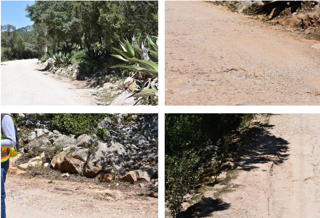
Figura 83. Condiciones actuales del escurrimiento superficial localizado en el km 7+060.
