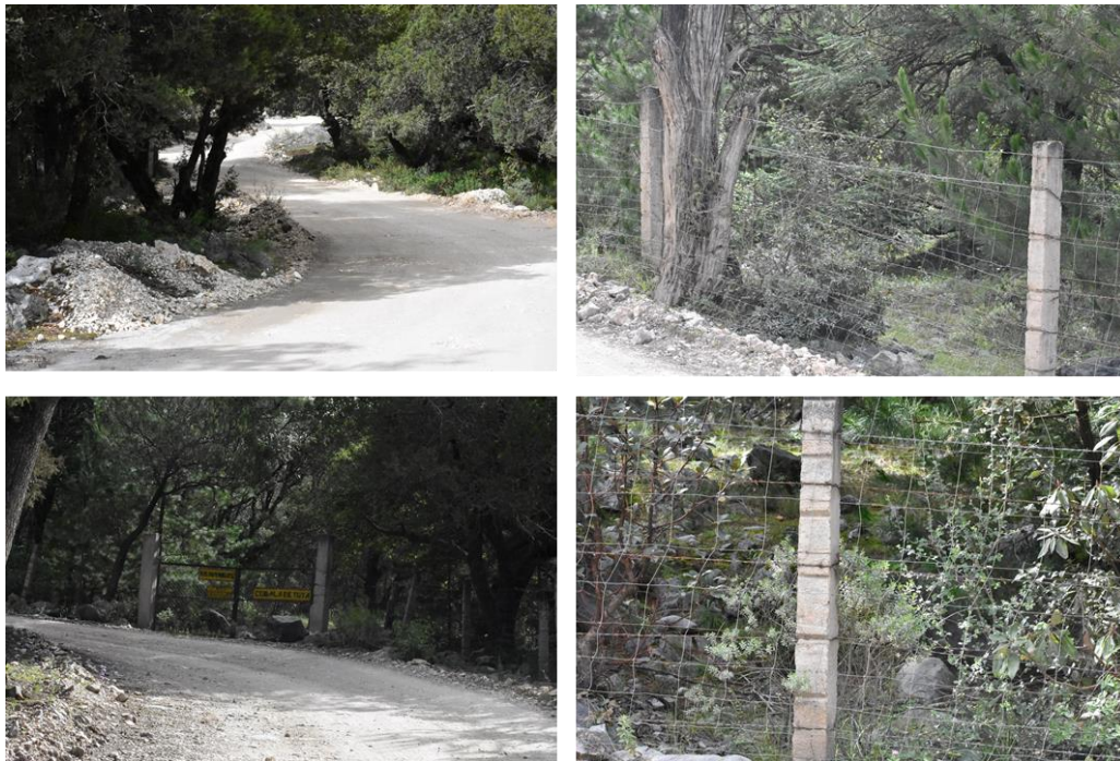
Figura 67. Condiciones actuales del escurrimiento superficial localizado en el km 1+130.
