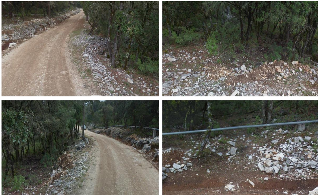
Figura 75. Condiciones actuales del escurrimiento superficial localizado en el km 3+139.
