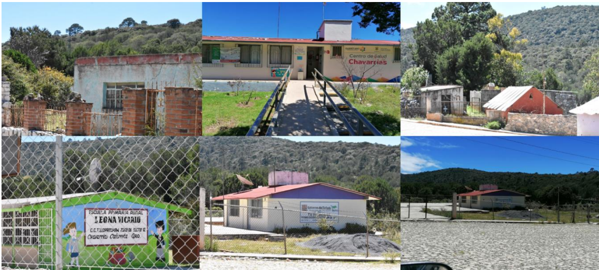
Figura 22. Comunidad de Chavarrías
