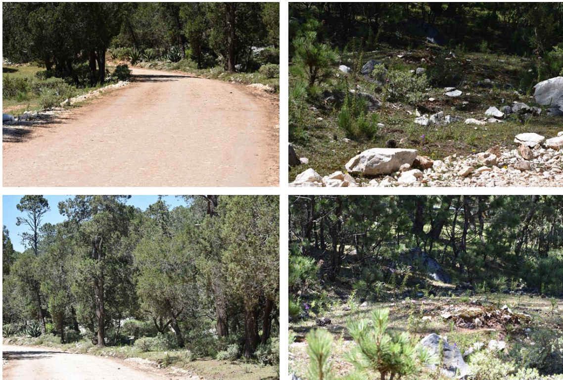
Figura 77. Condiciones actuales del escurrimiento superficial localizado en el km 5+205.
