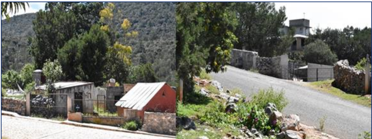
Figura 181. Viviendas en la comunidad de Chavarrías.
