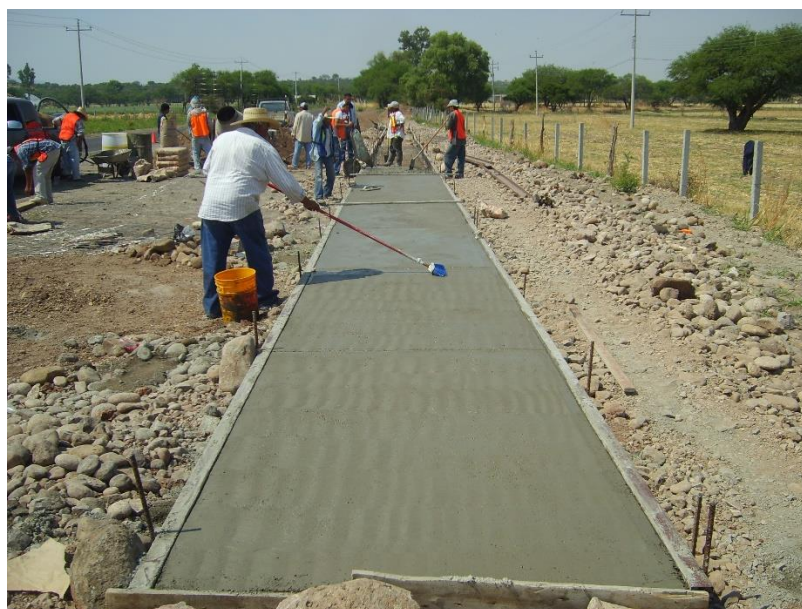
Figura 10. Colado de la losa de concreto y acabado aparente de un andador peatonal.
