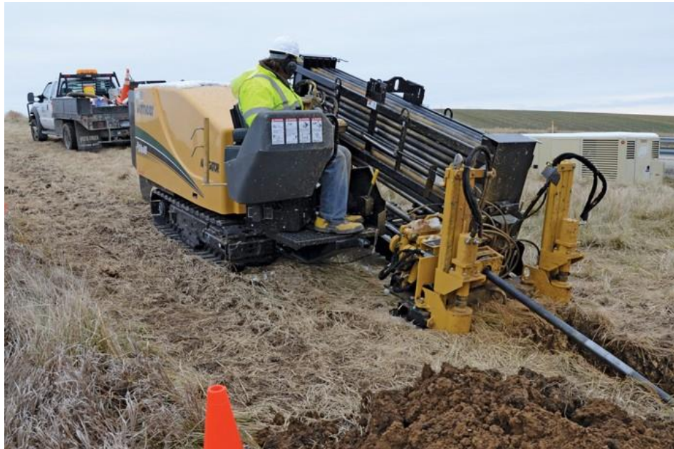
Figura 6. Maquinaria utilizada para la perforación horizontal dirigida PHD.
