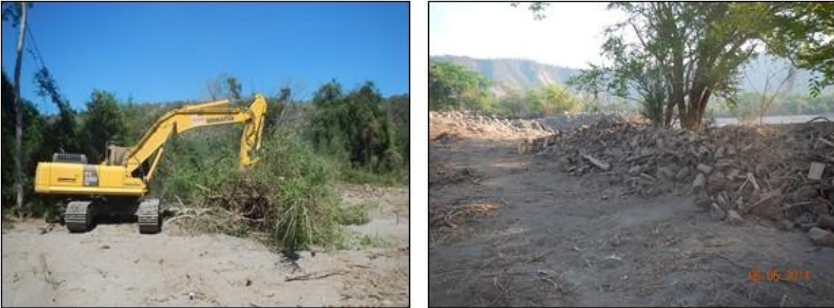
Figura 24. Desmonte y confinación de residuos con el uso de maquinaria.
