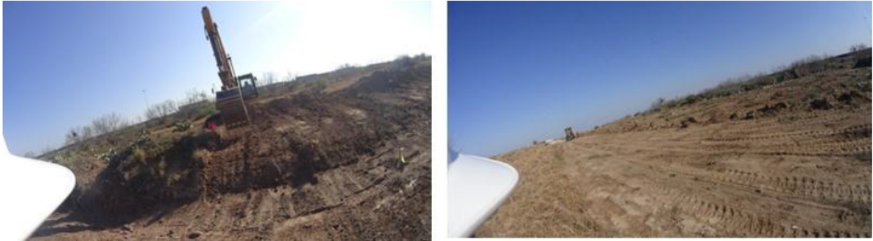
Figura 25. Despalme del suelo mineral
