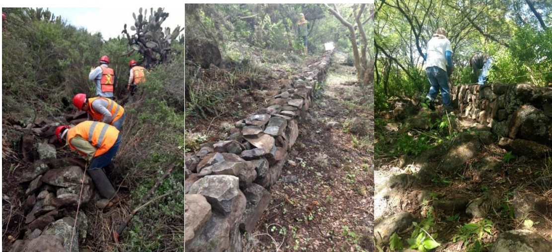
Figura 2. Construcción de las barreras de piedra acomodada.
