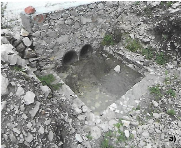
Fotografía II. 1. a) y b) Ejemplo del diseño de las alcantarillas a construirse para el proyecto
