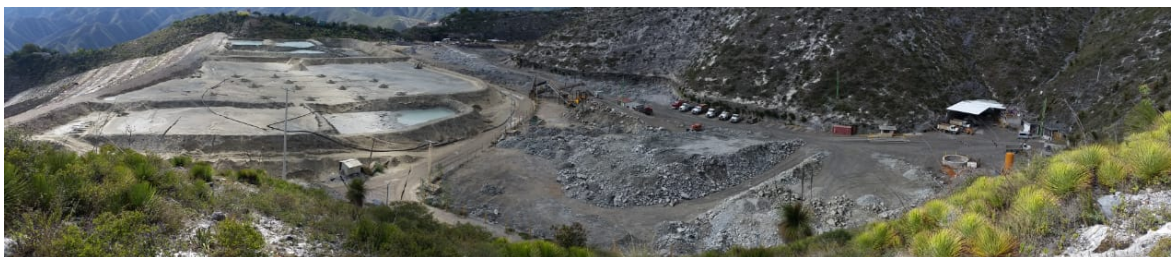
Figura II.5. Imagen del área de la corona superior del depósito de jales No 5. Vista hacia el sur-poniente, a la derecha el área de trituración de la empresa.
