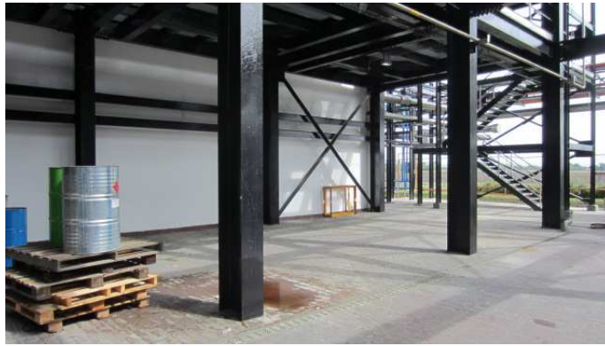
Fotos 1. Área para la instalación del proyecto Nectaryl, Kephalis y Limonile que consiste en: Una unidad de destilación multipropósito de 6 m 3 , 3 tanques receptores de 880L, 3.1 m 3 y 7.1 m 3 , un condensador tipo martillo, con empacado de columna tipo pall ring.
