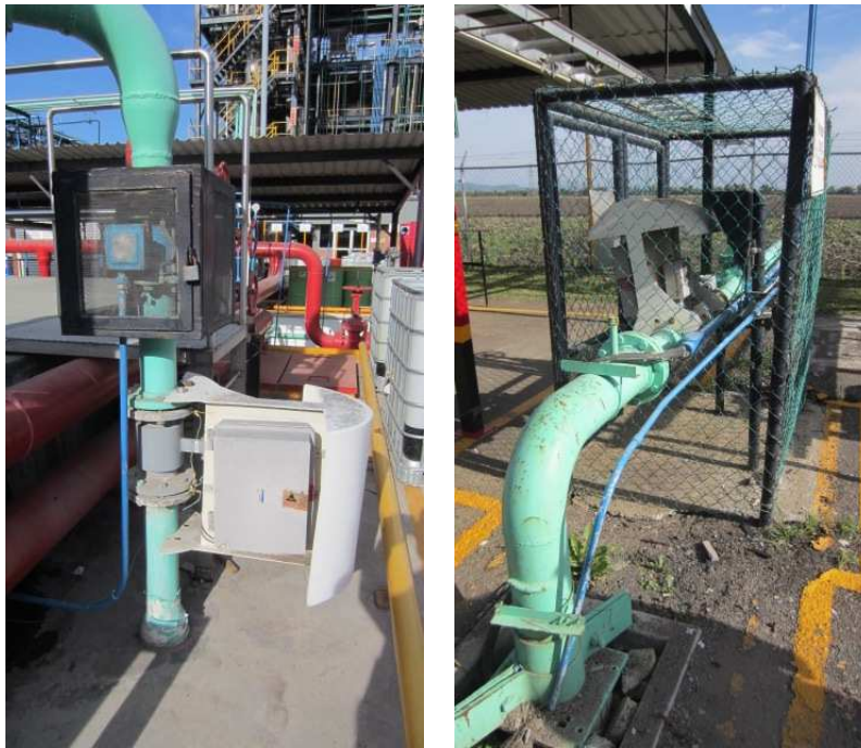
Foto 11. Pozo de Agua 1 (principal)
