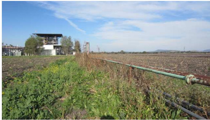
Foto 5. Tubería a reubicar para calle de acceso
