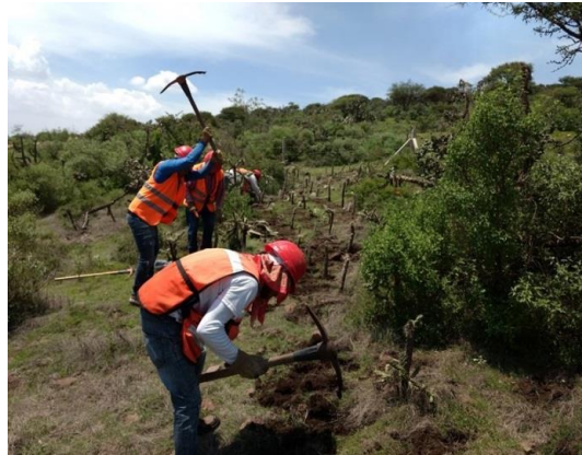
Figura 44. Ejemplo de excavación y construcción de la terraza individual.
