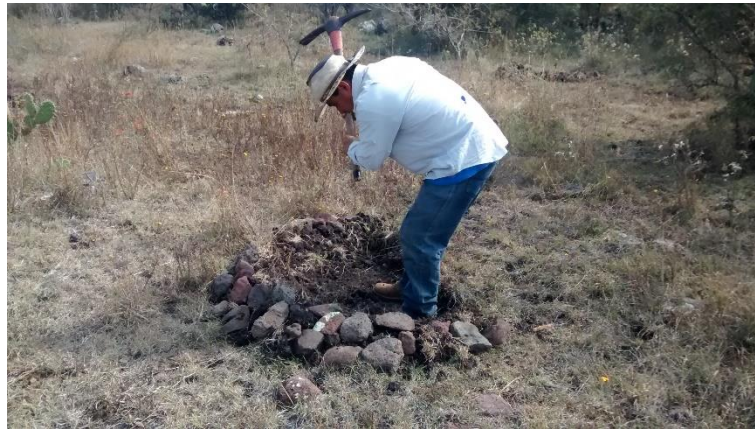
Figura 20. Formación de terraza individual con refuerzo de piedra
