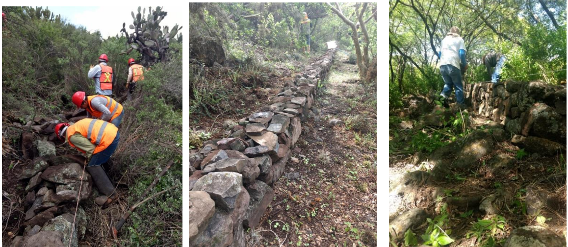
Figura 9. Construcción de las barreras de piedra acomodada.
