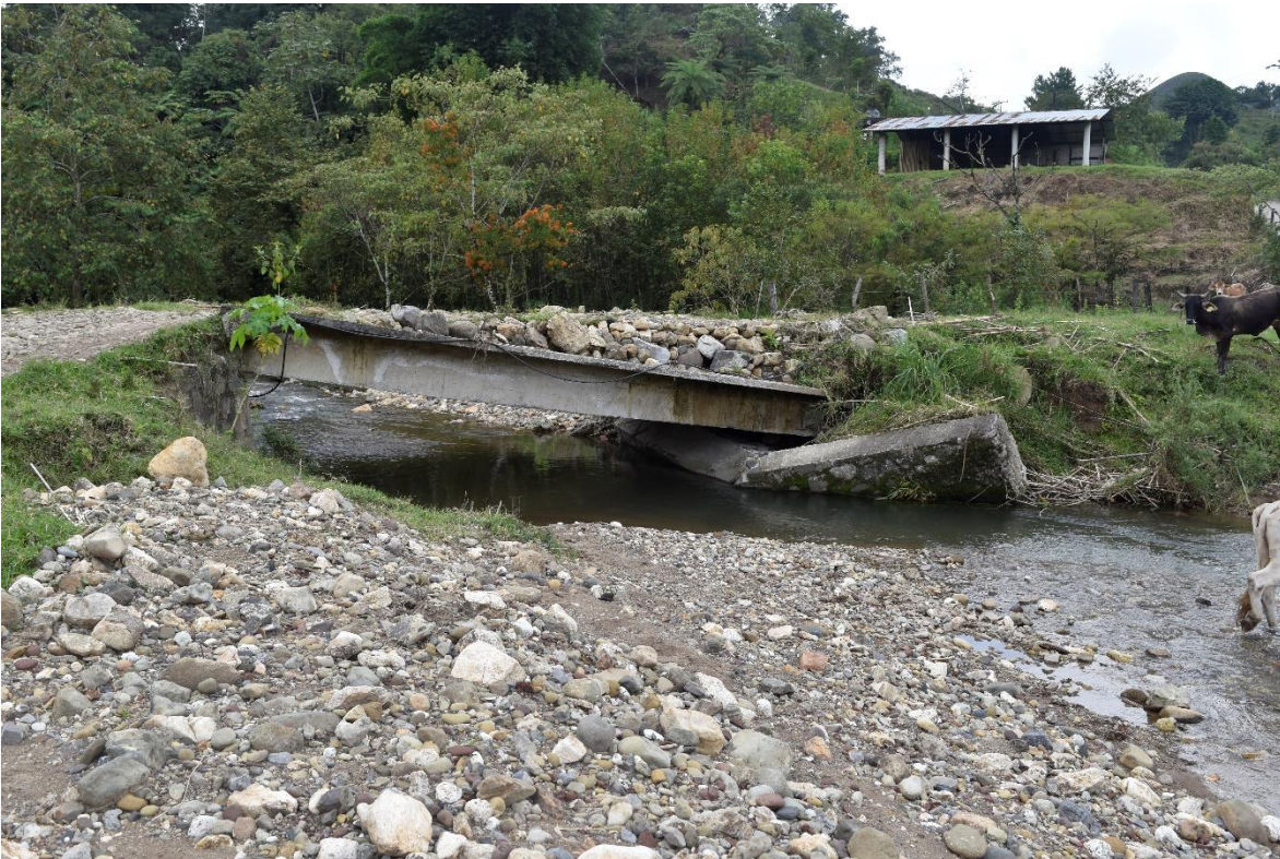
Fotografía del puente y las condiciones actuales en su periferia.
