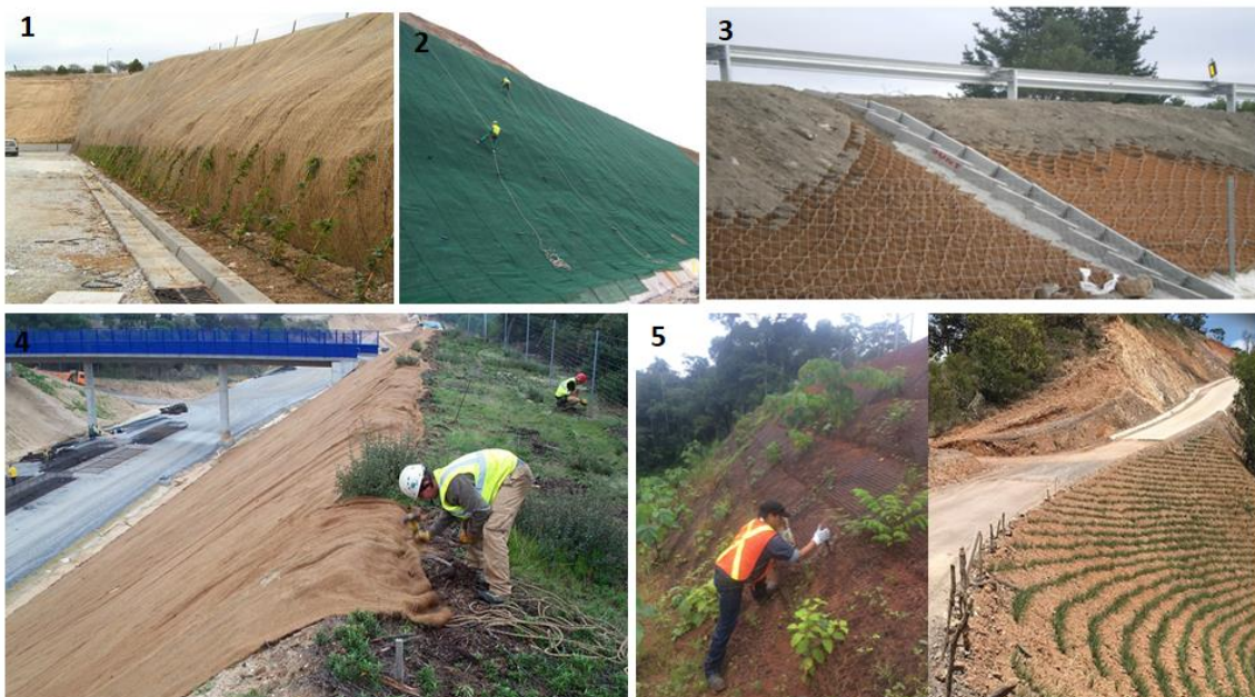
Fotografía 1. 1.Mallas o enrejados metálicos, 2. Geomallas volumétricas, 3. Geoceldas, 4. Mantas orgánicas 5. Revegetación.
