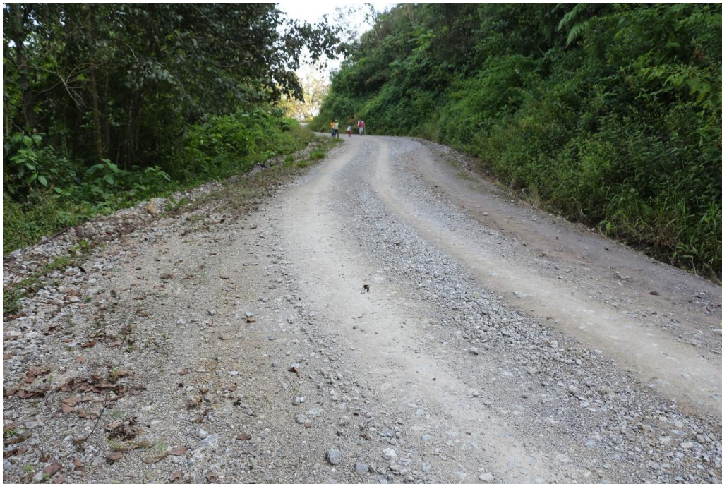
Fotografía 2. Fotografía del camino desviación de Alseseca a Cuahueyatla vía desviación Ayohuixcuatla en el km 6+400.
