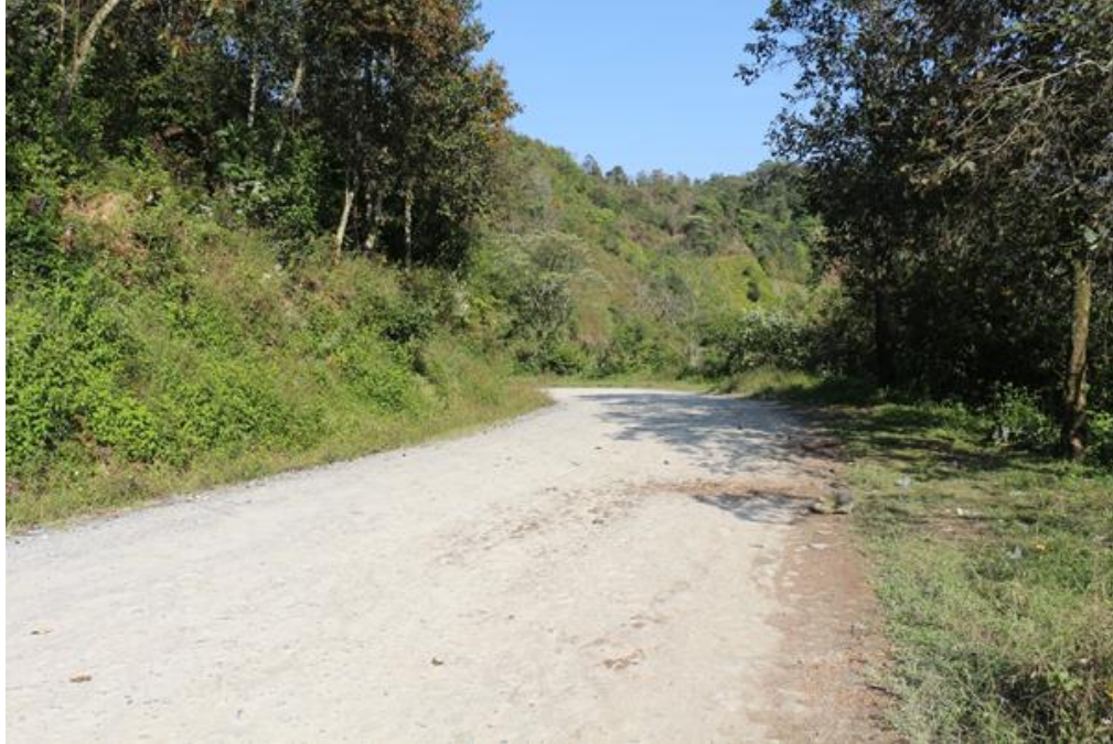
Fotografía 1. Fotografía del camino Cuacuila-Xaltepec en el km 1+500.
