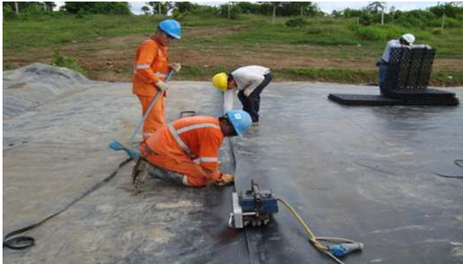
Imagen 17. Instalación de geomembrana
