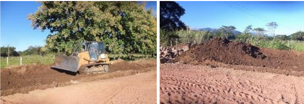
Figura VI. 8. Ejemplos de almacenamiento de la capa vegetal
