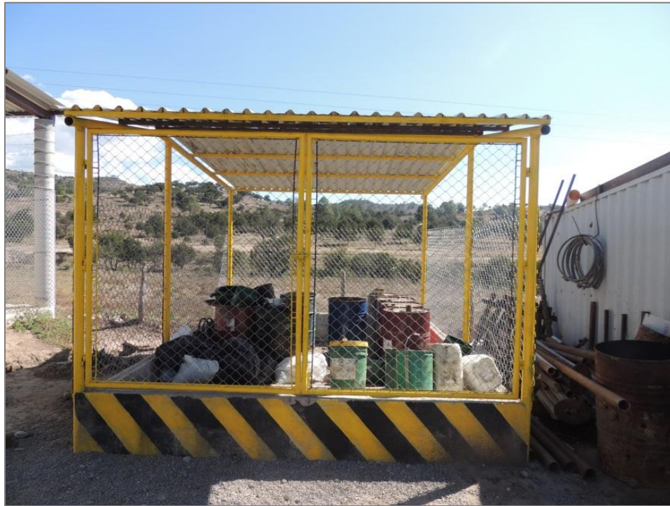
Imagen 23. Almacén de residuos peligrosos
