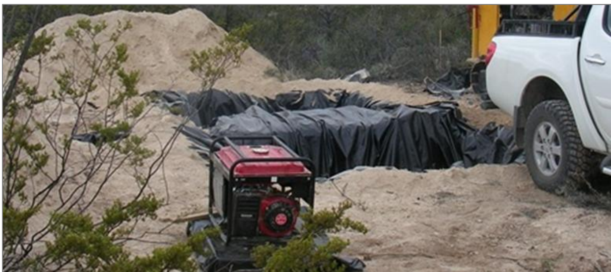
Imagen 17. Fosas o cárcamos de recirculación de lodos, y su forma de impermeabilización
