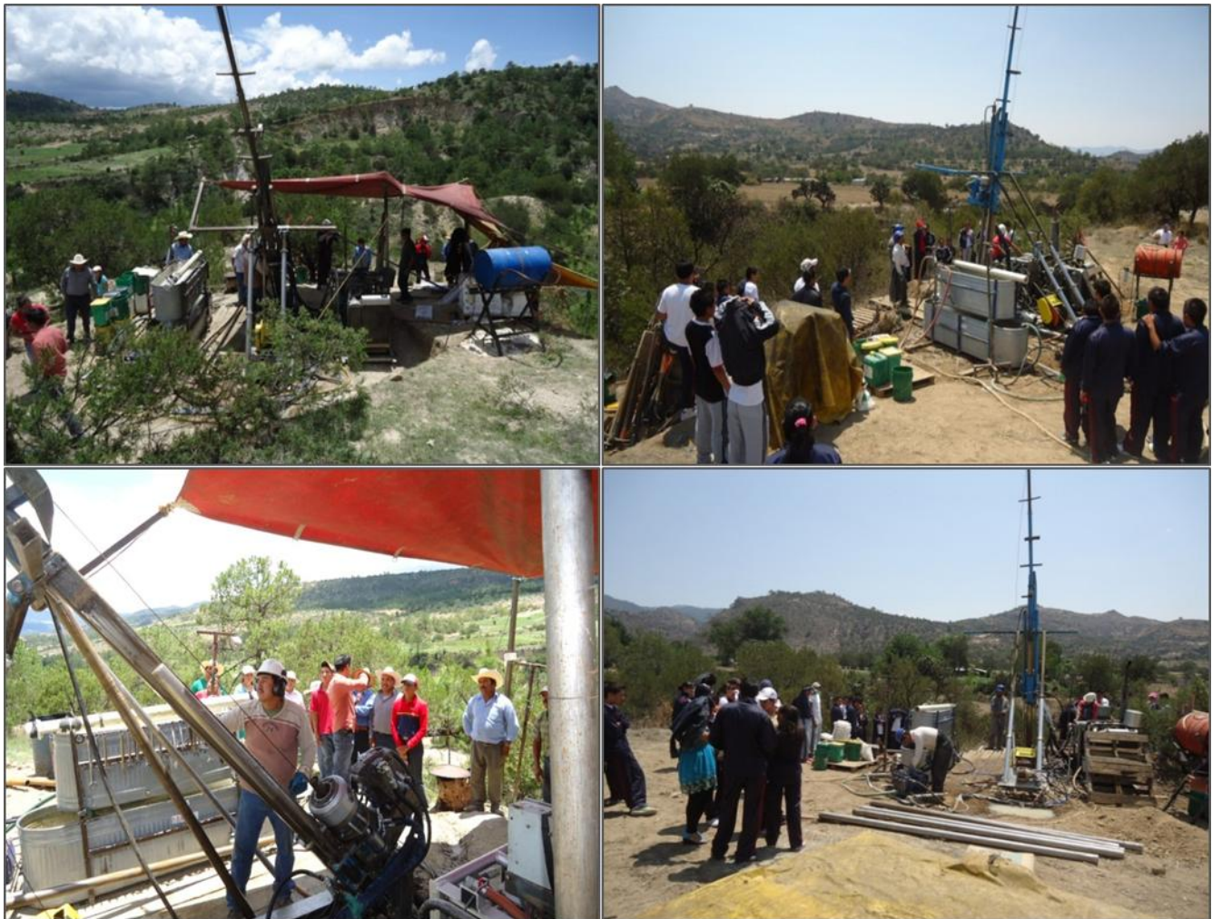
Imagen 21. Operación de la máquina perforadora para la extracción de núcleos (Fotos de archivo)
