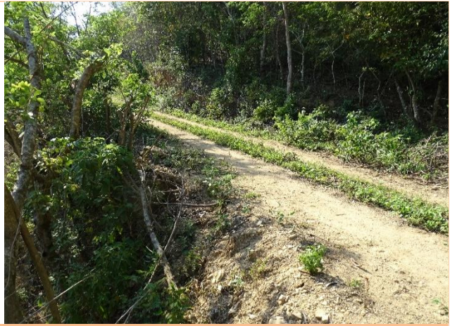
Vista de la obra de drenaje 01.
