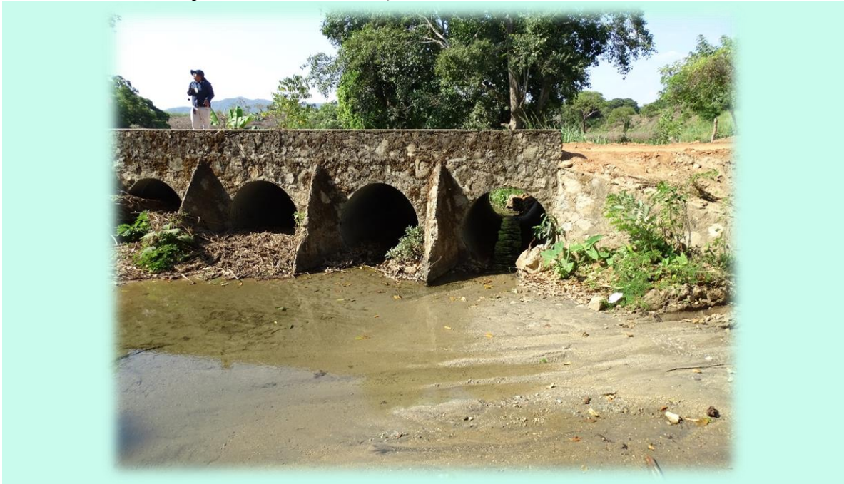
Fotografía V. 3. Obras de drenaje existentes usadas como paso de fauna.
