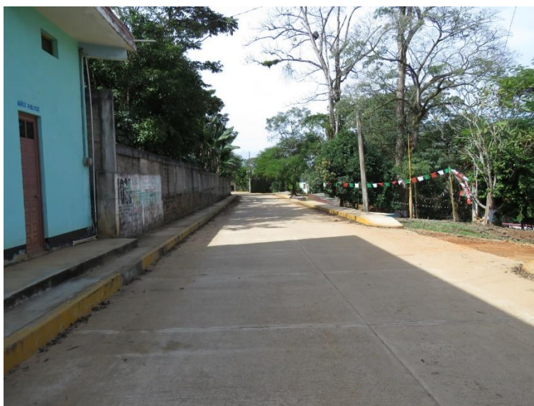
Fotografía II. 1. Inicio del proyecto
