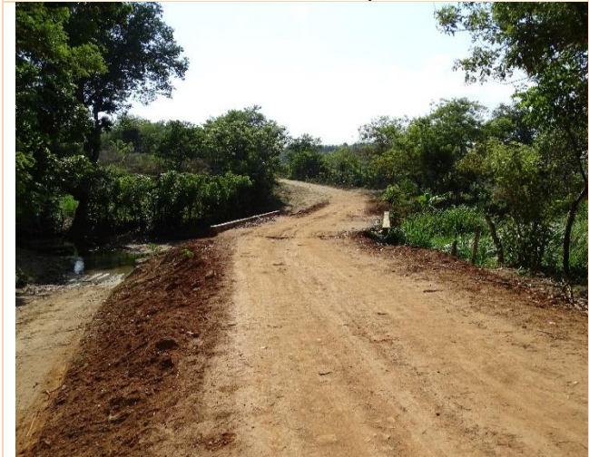
Vista del puente existente
