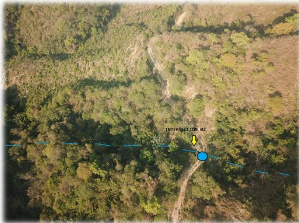
Imagen IV. 41. Fotografía de la intersección del camino con el cauce intermitente 02
