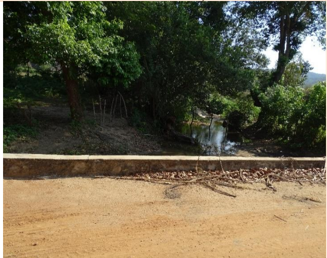
Vista del puente existente.
