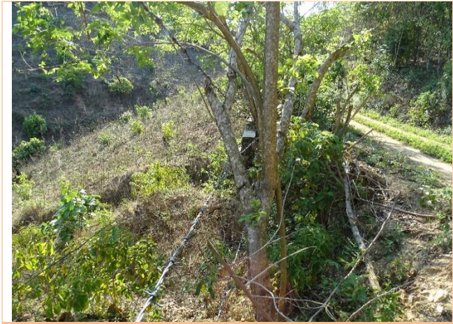
Vista de la obra de drenaje 01.
