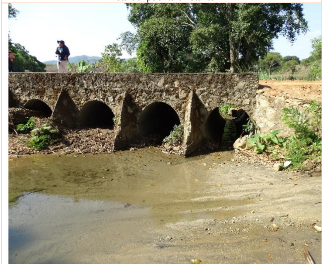
Vista de puente existente.
