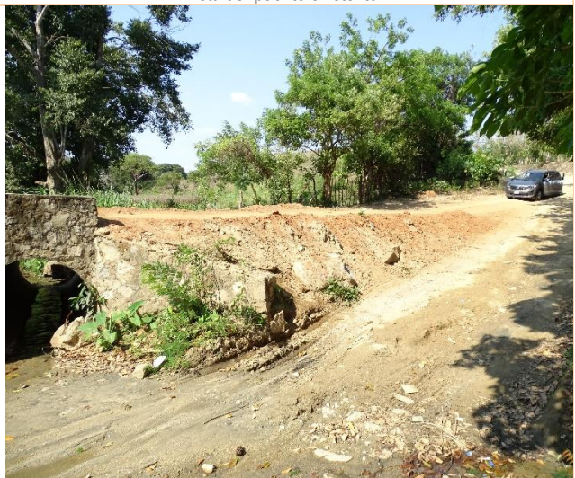
Vista del puente existente.
