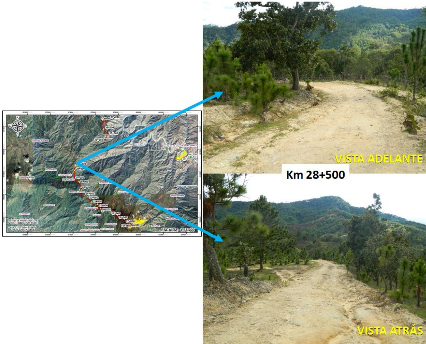
Ilustración IV-34. Ubicación del km 28+500, vista adelante y atrás, fin del tramo uno, donde se realizará la modernización y ampliación del camino.
