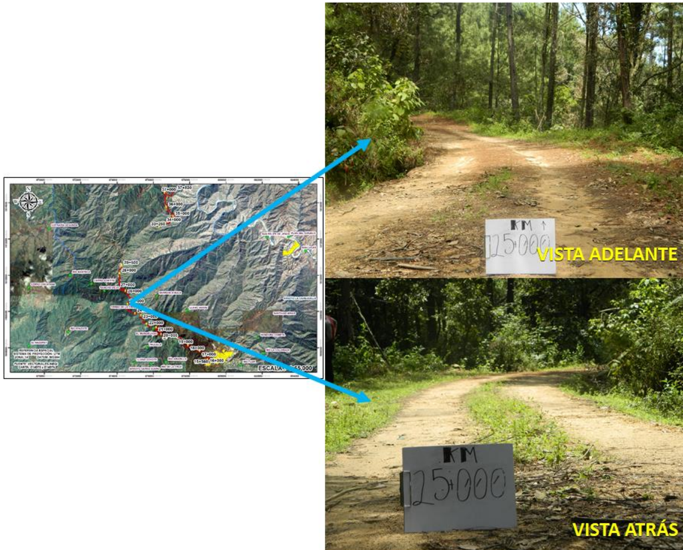
Ilustración IV-30. Ubicación del km 25+000, vista adelante y atrás.
