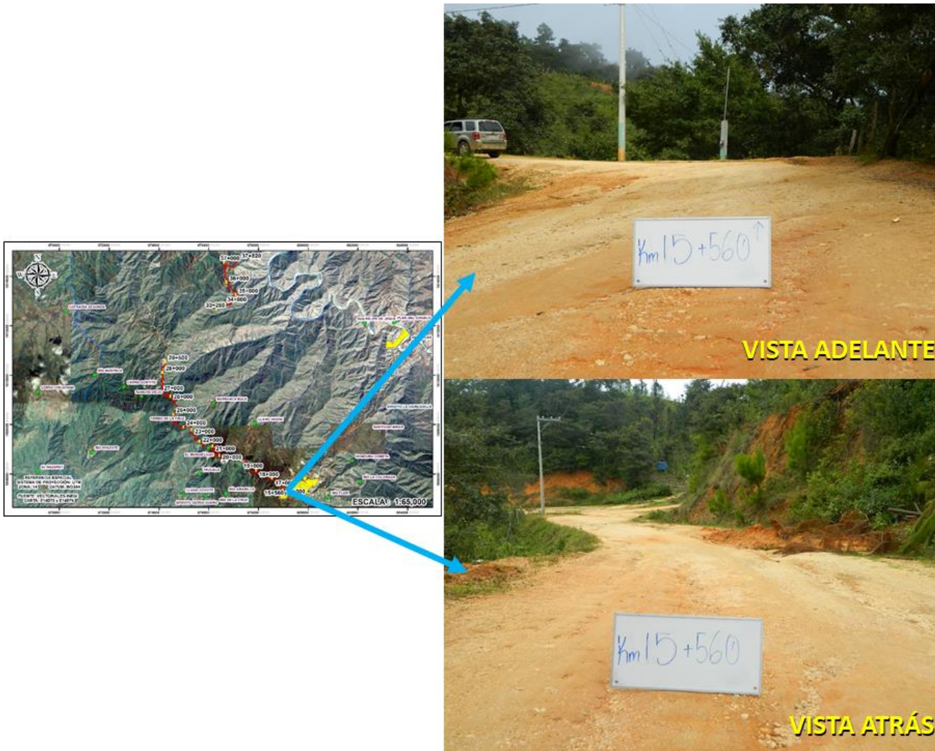
Ilustración IV-20. Ubicación del km 15+560, inicio del camino, tramo uno.
