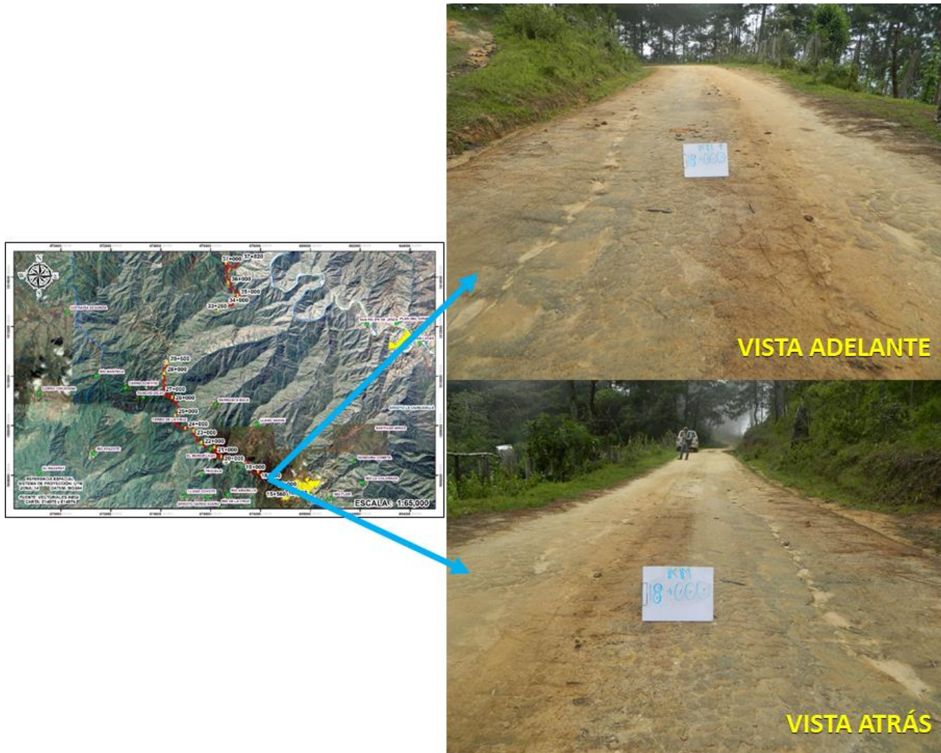
Ilustración IV-23. Ubicación del km 18+000, vista adelante y atrás.
