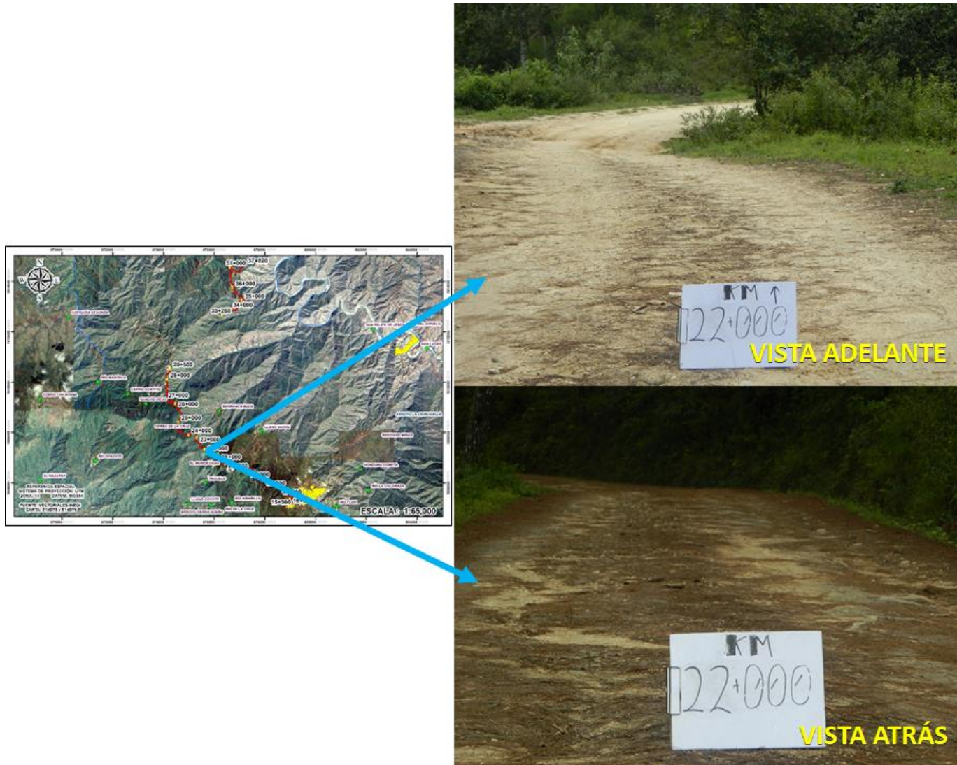
Ilustración IV-27. Ubicación del km 22+000, vista adelante y atrás.
