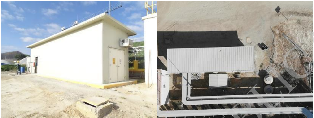
Figura 2.18. Vista general del Cuarto de control de trituración y vista aérea tomada con Dron en marzo de 2019
