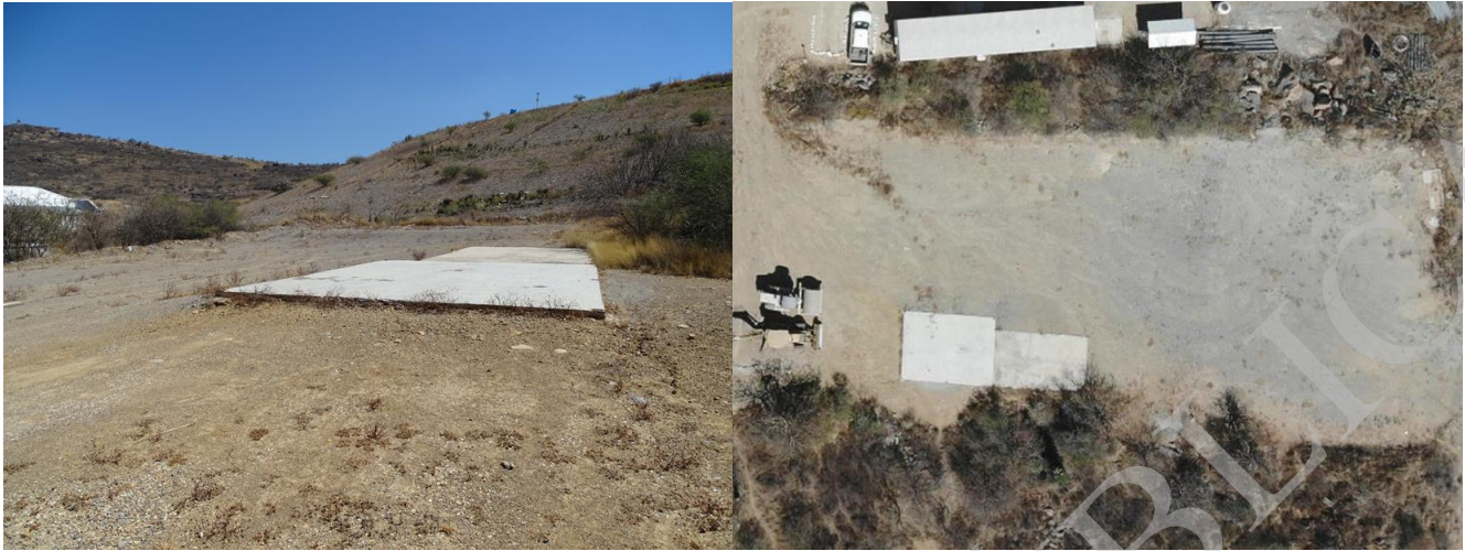
Figura 2.58. Vista general del Patio de contratistas y vista aérea tomada con Dron en marzo de 2019
