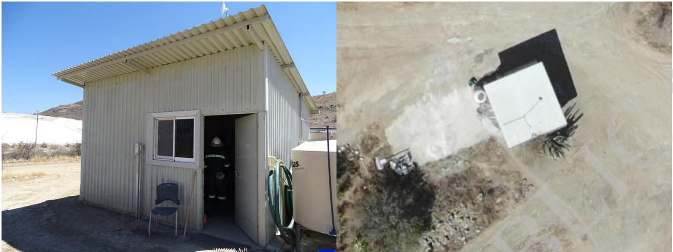
Figura 2.57. Vista general del Laboratorio de pruebas del Dry stack y vista aérea tomada con Dron en marzo de 2019
