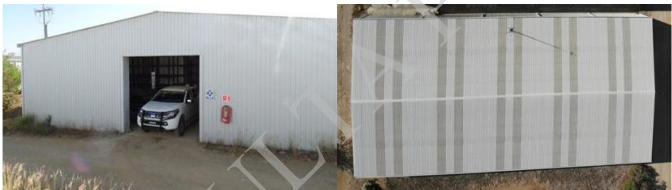
Figura 2.12. Vista general del almacén de núcleos 4 y vista aérea tomada con Dron en marzo de 2019
