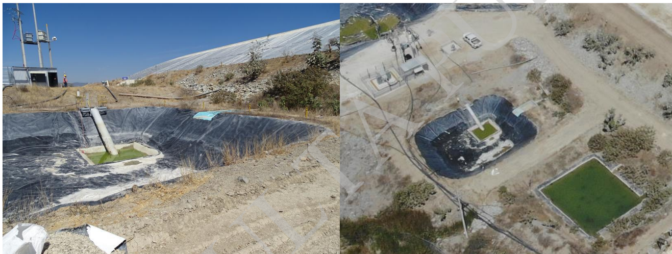
Figura 2.60. Vista general de la Pileta de colecta del Dry stack y vista aérea tomada con Dron en marzo de 2019
