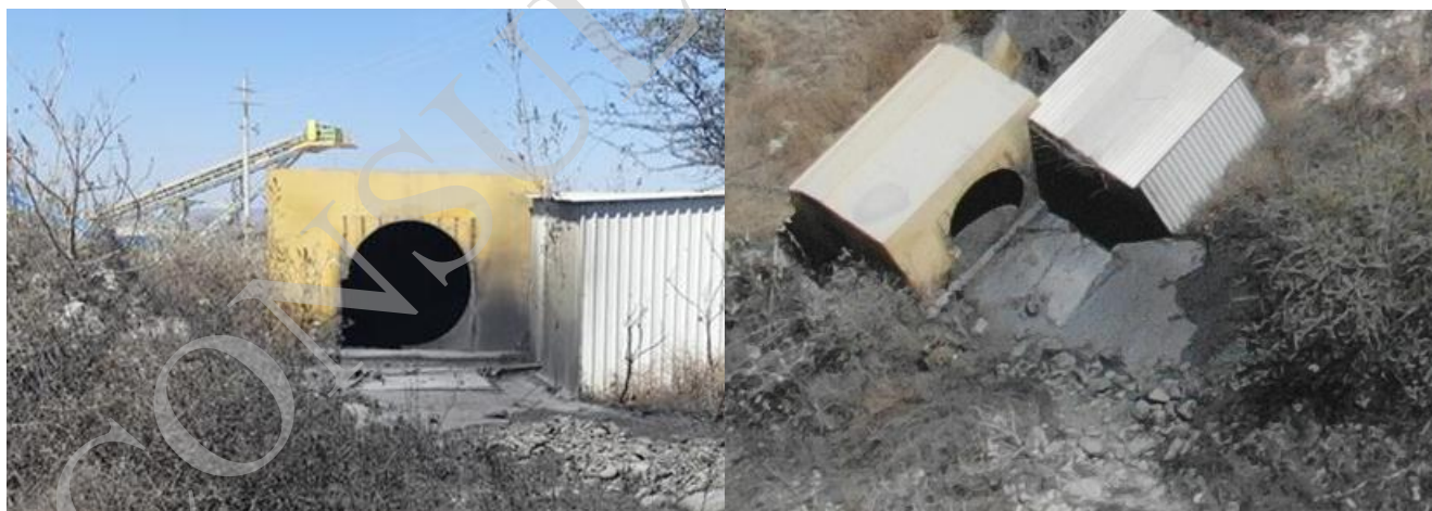
Figura 2.46. Vista general del Contrapozo de ventilación y vista aérea tomada con Dron en marzo de 2019
