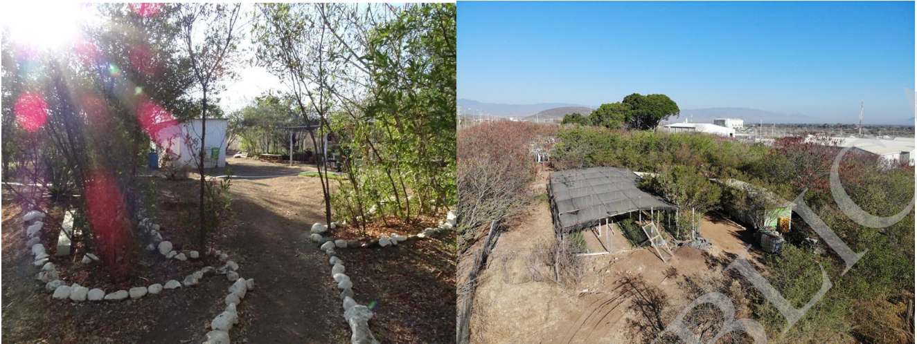
Figura 2.62. Vista general del Vivero y bodega y vista aérea tomada con Dron en marzo de 2019
