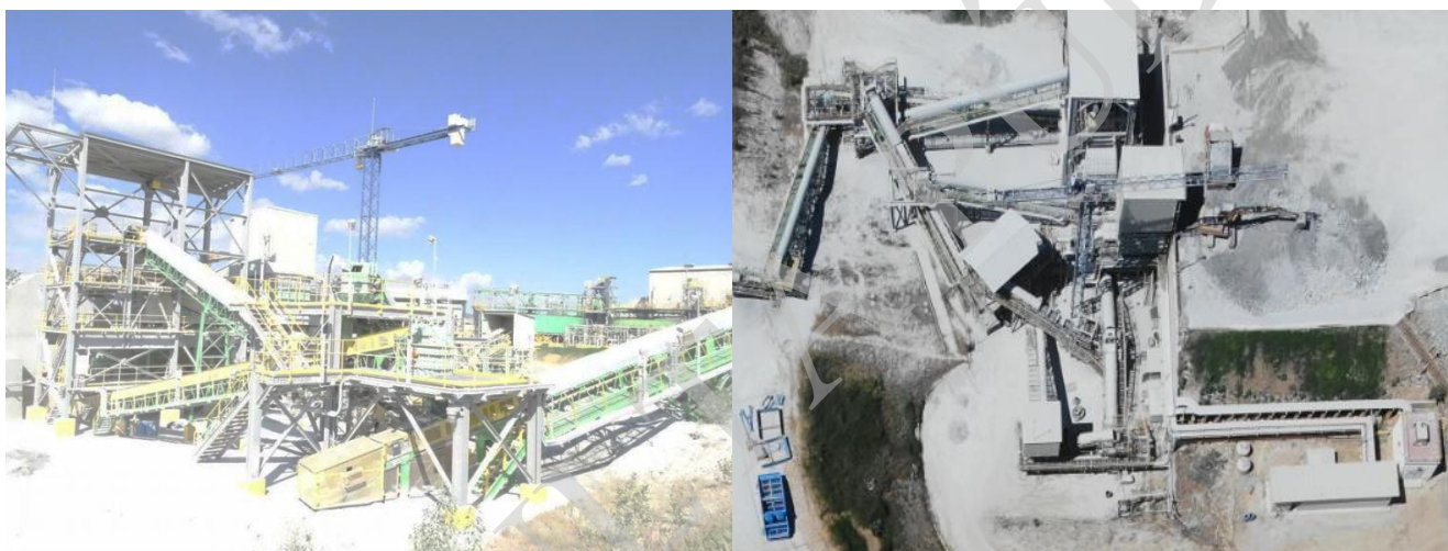
Figura 2.64. Vista general del área de trituración y vista aérea tomada con Dron en marzo de 2019
