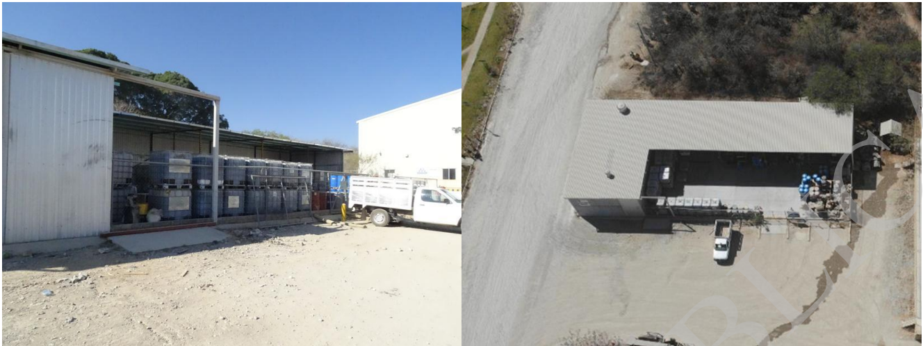
Figura 2.72. Vista general de Almacén de reactivos y área donde se localiza la fosa de captación de agua pluvial y vista aérea tomada con Dron en marzo de 2019
