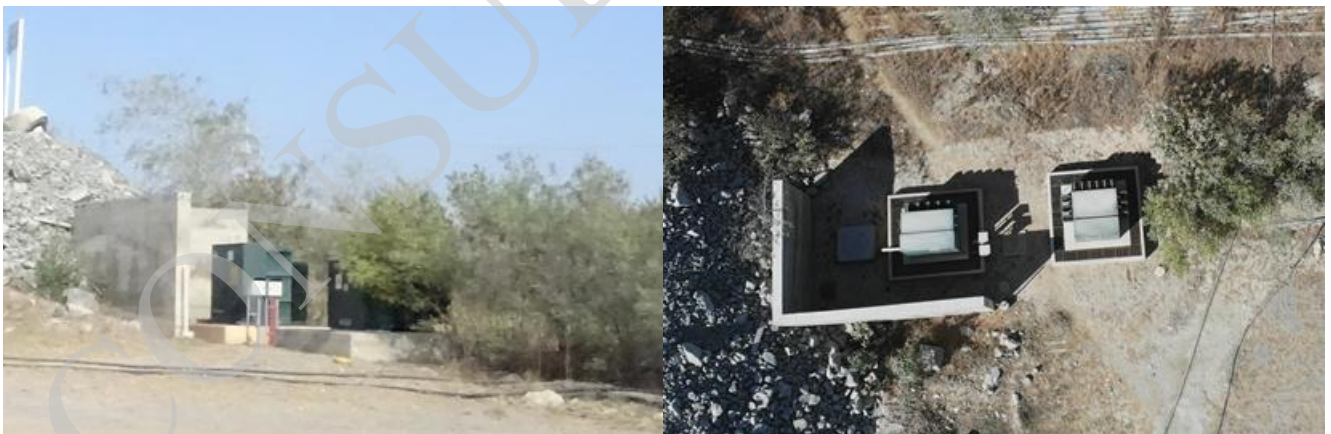
Figura 2.20. Vista general de los dos transformadores eléctricos y vista aérea tomada con Dron en marzo de 2019
