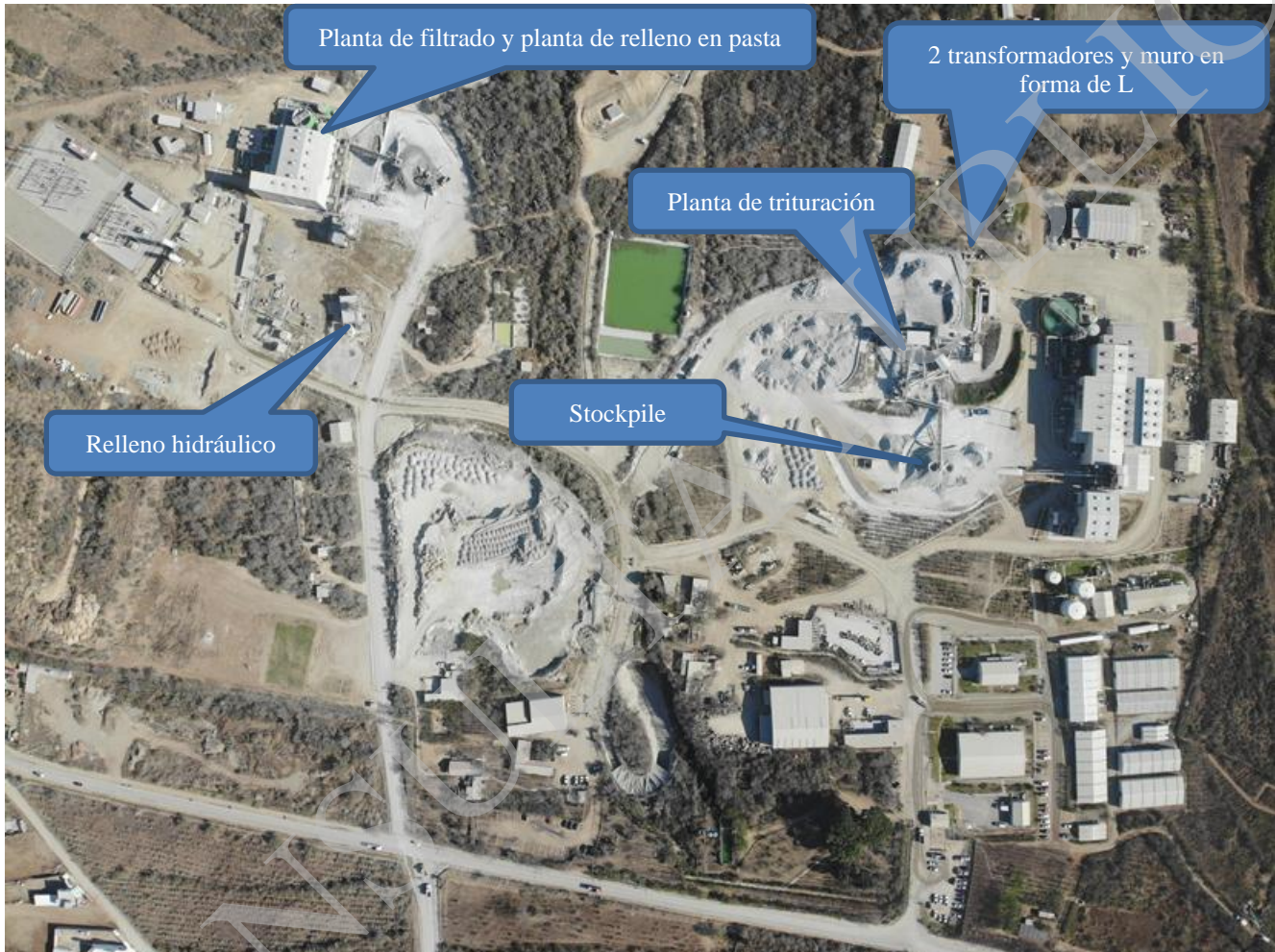
Figura 2.68. Vista aérea tomada con Dron en marzo de 2019, se muestran algunas de las obras que conforman la Obra denominada Planta de beneficio y que ya han sido consideradas en esta MIA-R para su evaluación.
