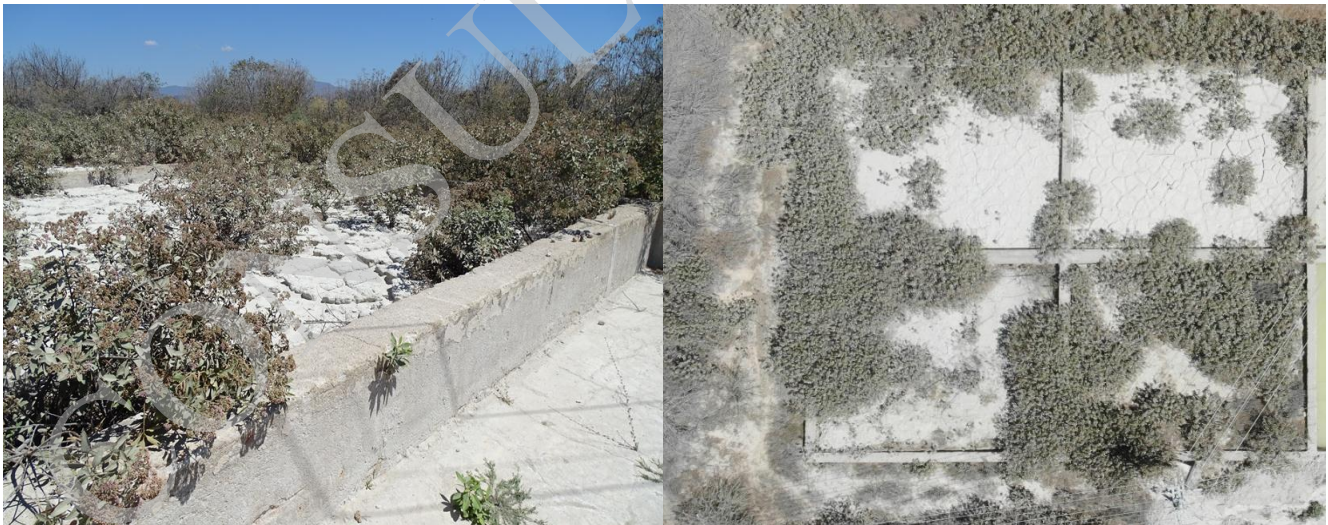
Figura 2.45. Vista general de las Piletas y vista aérea tomada con Dron en marzo de 2019
