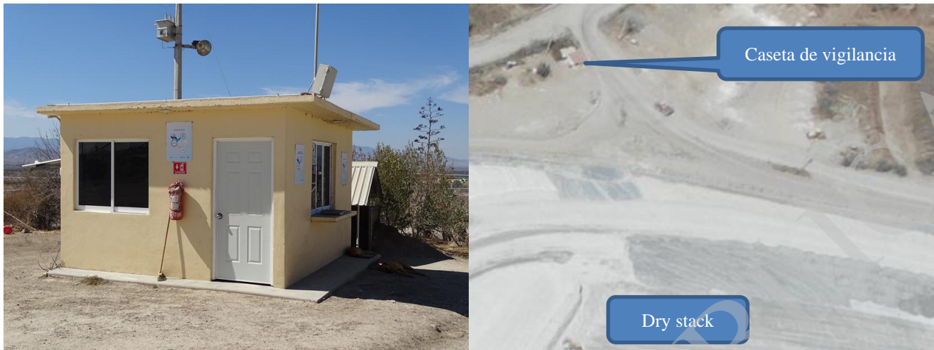
Figura 2.54. Vista general de la caseta de vigilancia y vista aérea tomada con Dron en marzo de 2019
