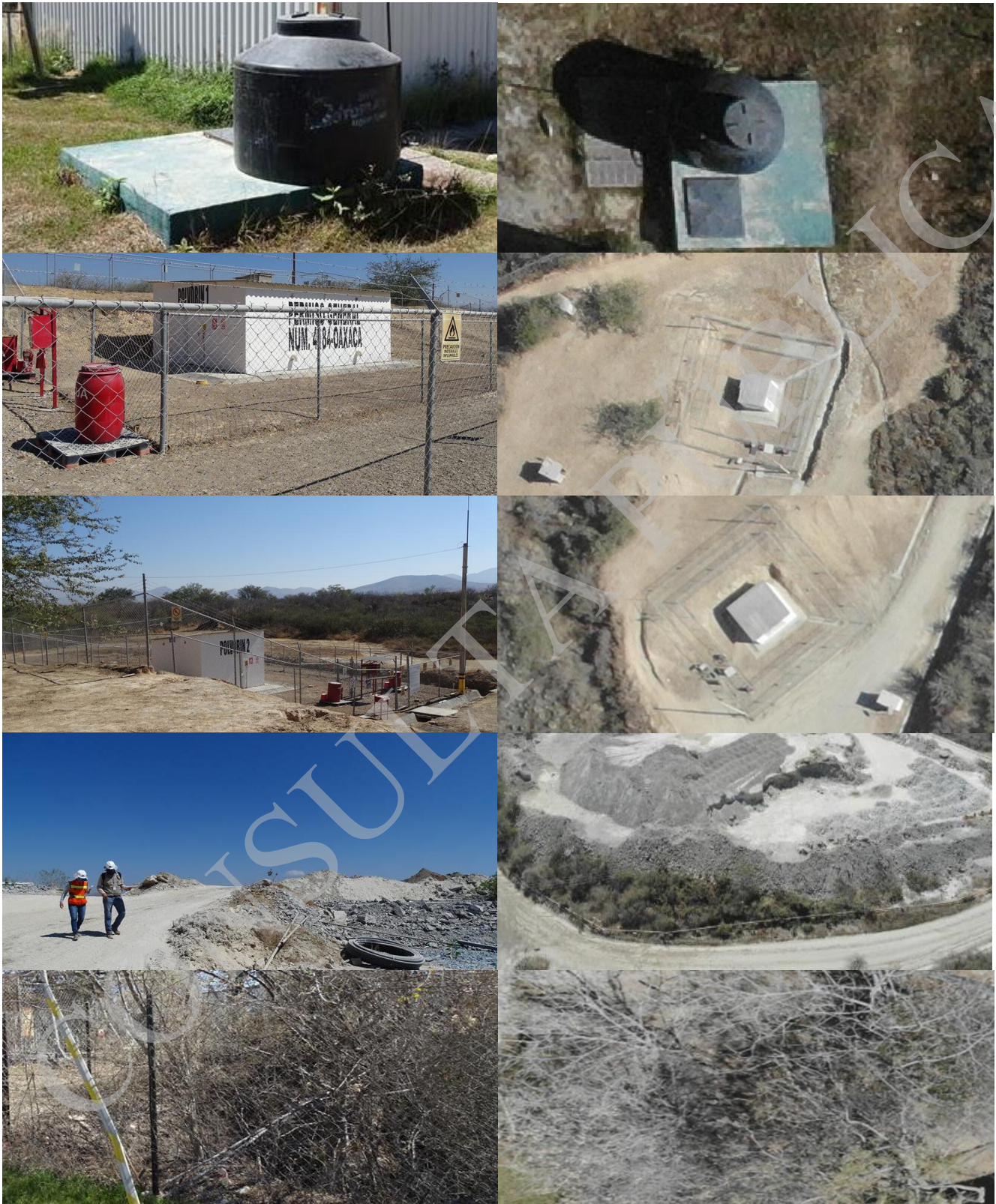
Figura 2.80. Vista general de las obras con Id. 73, 74, 75, 76 y 77 y vista aérea tomada con Dron en marzo de 2019
