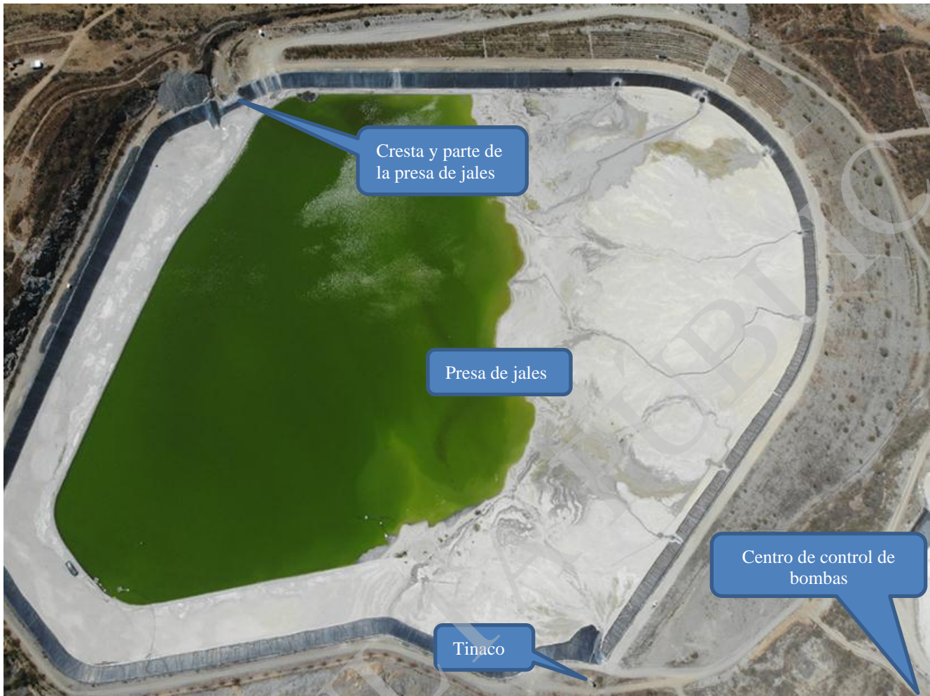
Figura 2.69. Vista aérea tomada con Dron en marzo de 2019, se muestran algunas de los componentes mencionados que conforman la Obra denominada Presa de Jales.
