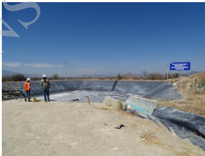
Figura 2.59. Vista general de la Pileta
