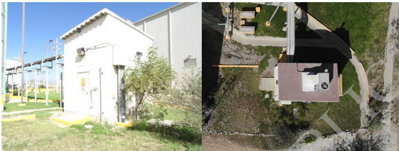
Figura 2.15. Vista general del centro de control de motores y vista aérea tomada con Dron en marzo de 2019
