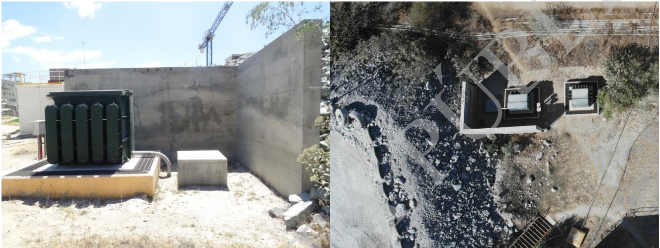
Figura 2.21. Vista general del Muro de contención de concreto en forma de L y vista aérea tomada con Dron en marzo de 2019
