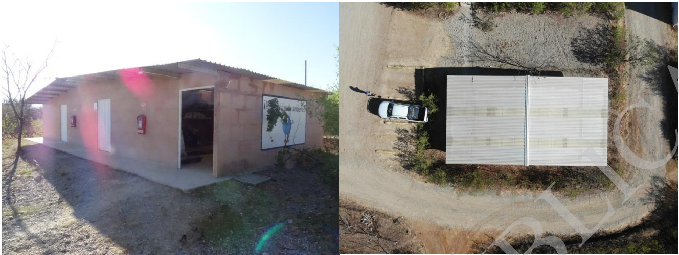
Figura 2.7. Vista general del almacén de núcleos y vista aérea tomada con Dron en marzo de 2019
