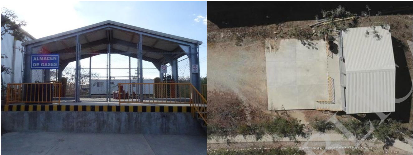
Figura 2.29. Vista general del almacén de gases y vista aérea tomada con Dron en marzo de 2019
