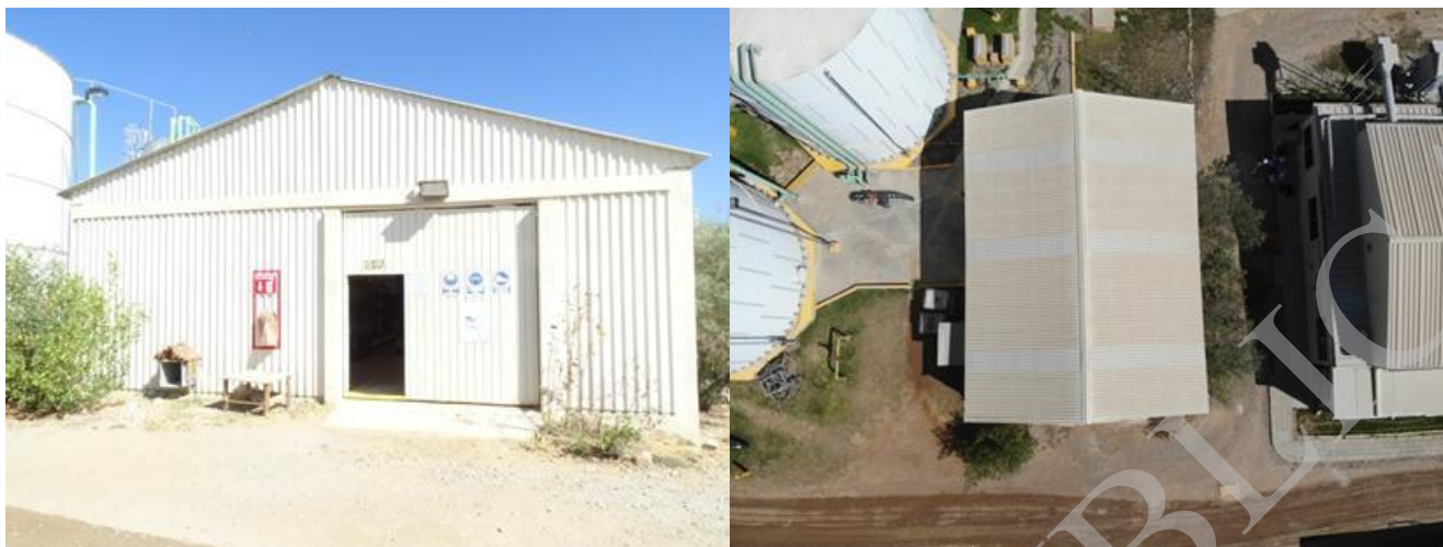
Figura 2.14. Vista general del área de pulimiento y vista aérea tomada con Dron en marzo de 2019
