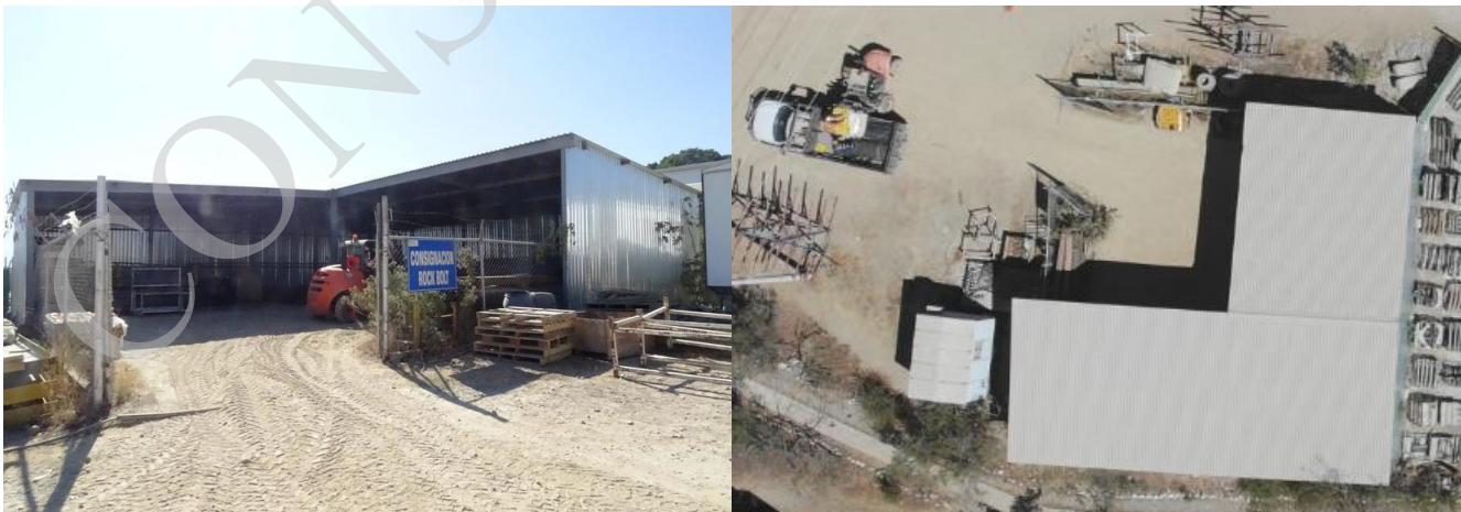
Figura 2.78. Vista general del Almacén y vista aérea tomada con Dron en marzo de 2019
