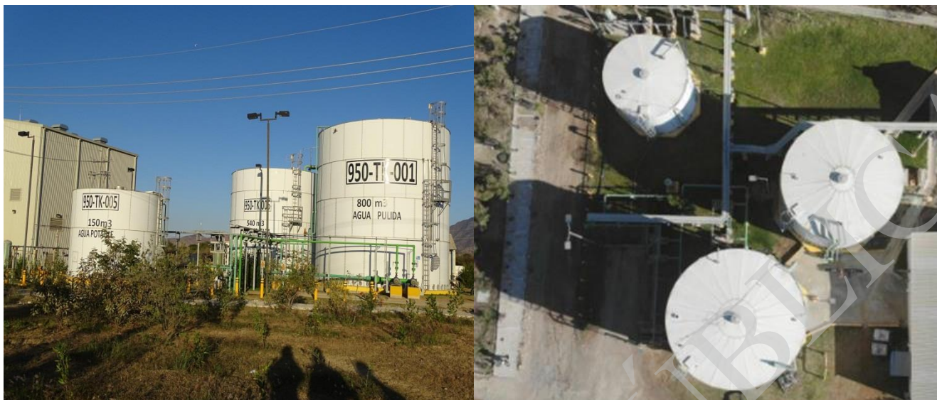
Figura 2.75. Vista general de los Tanque de almacenamiento de agua y vista aérea tomada con Dron en marzo de 2019
