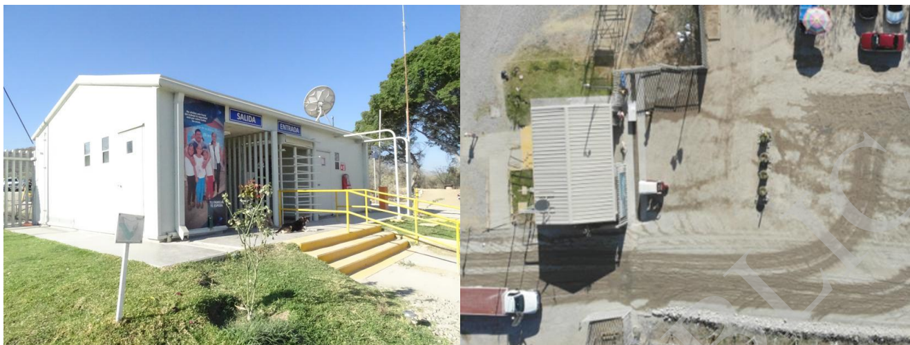
Figura 2.73. Vista general de la caseta de Vigilancia del acceso a la mina y vista aérea tomada con Dron en marzo de 2019
