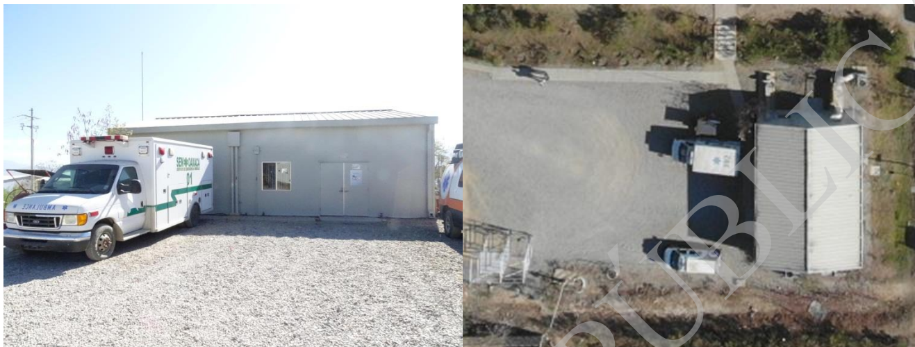
Figura 2.71. Vista general del área de servicios médicos y vista aérea tomada con Dron en marzo de 2019
