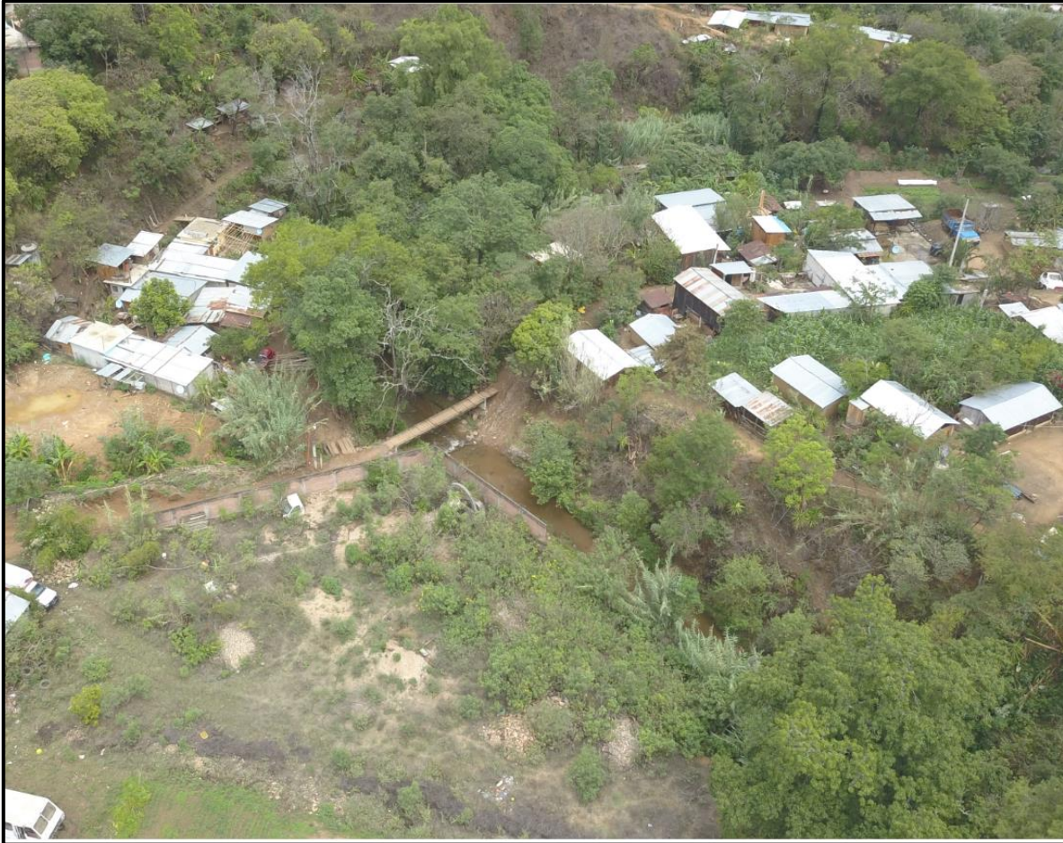
IMAGEN IV.2.- RIO SAN PABLO, QUE CRUZA EL PROYECTO DEL PUENTE VEHICULAR.
