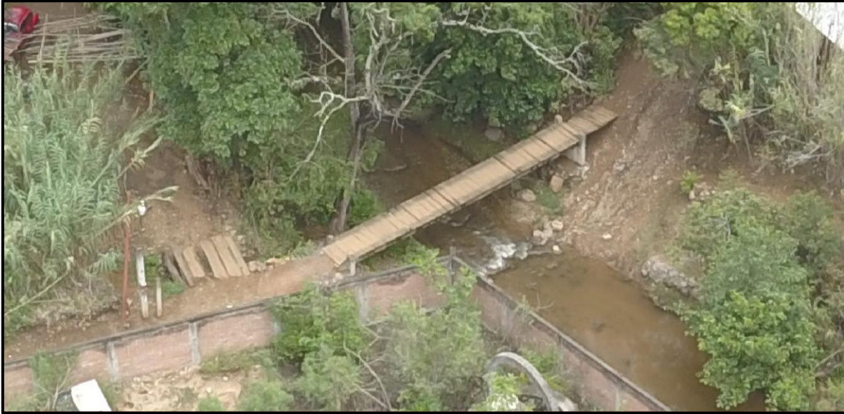
IMAGEN IV. 4. ACERCAMIENTO AL SITIO DONDE SE CONSTRUIRÁ EL PUENTE. SE MUESTRA LA VEGETACIÓN ALDEÑA AL PUENTE ACTUAL EL CUAL NO SERA AFECTADO
