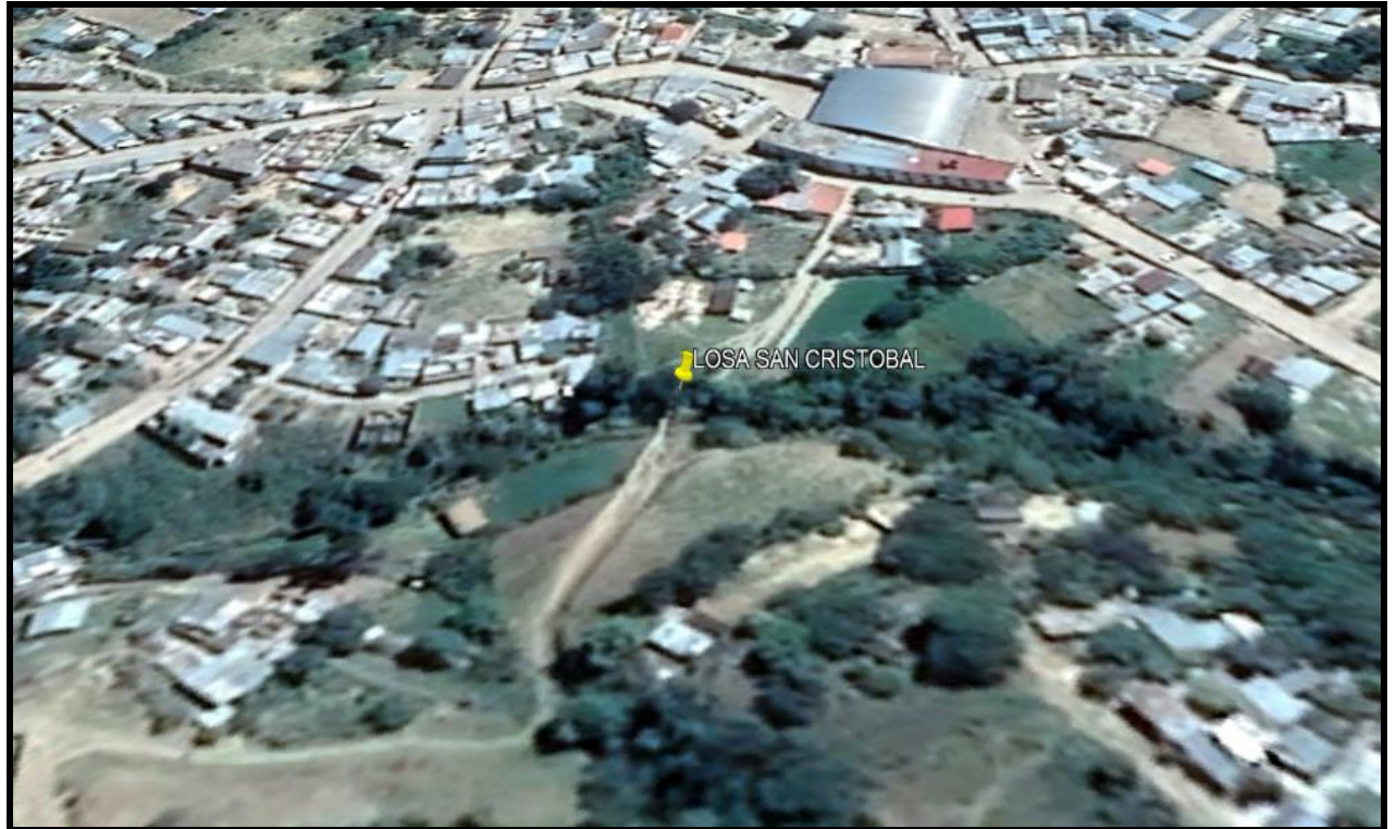
Imagen 02. Vista general de la ubicación del puente.
