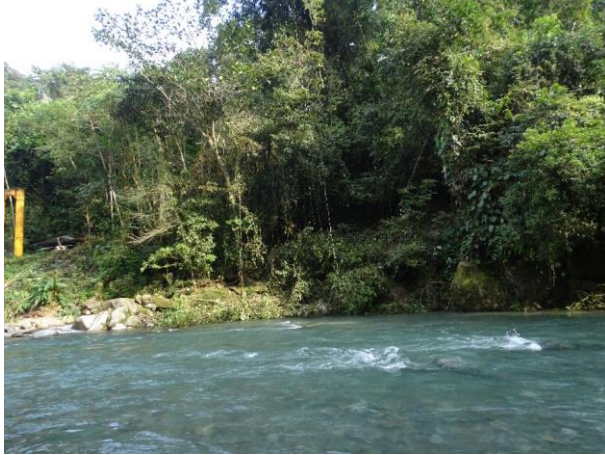
Fotografía 5. Vista de ubicación del dentro del eje del puente. Dirección oeste-este.
