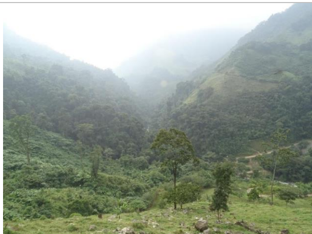
Fotografía 1. Vista general del sitio de construcción del puente.
