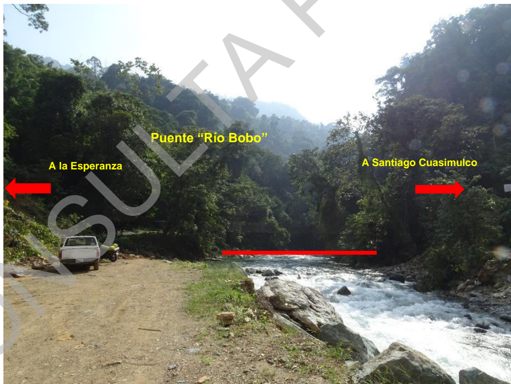
Imagen II.1 Ubicación del puente en el sitio de cruce.
